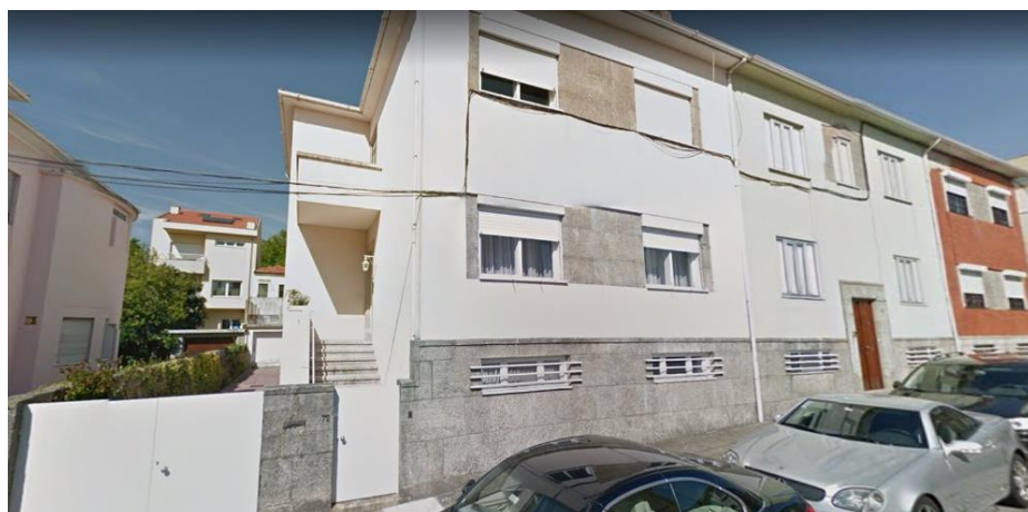
Fig. 3.1 - Vista geral do edifício (Fonte: Google Maps)
