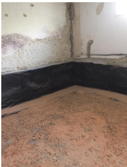
Fig. 3.10 - Aplicação da tela asfáltica na cave
