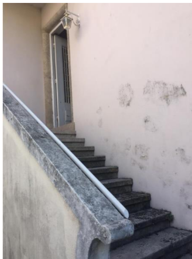
Fig. 3.12 - Escadas exteriores no alçado lateral (Entrada principal da habitação)
