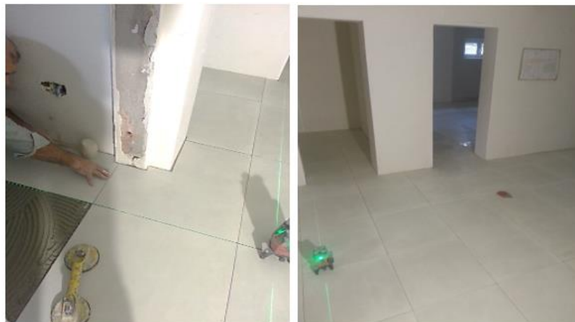
Fig. 3.24 - Aplicação do mosaico cerâmico (Cave)
