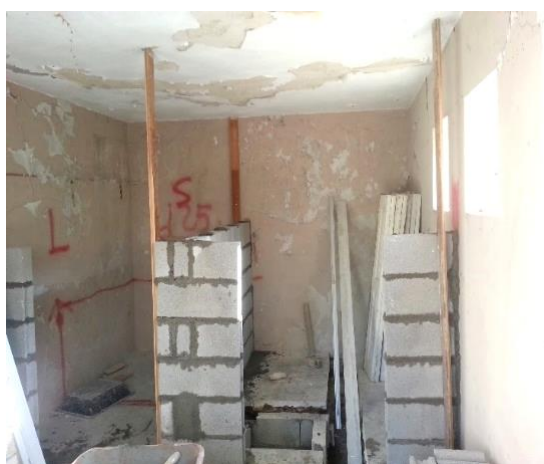
Fig. 3.26 – Execução das paredes divisórias (Anexo)
