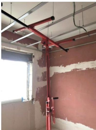
Fig. 3.21 - Estrutura para instalação de tetos em gesso cartonado
