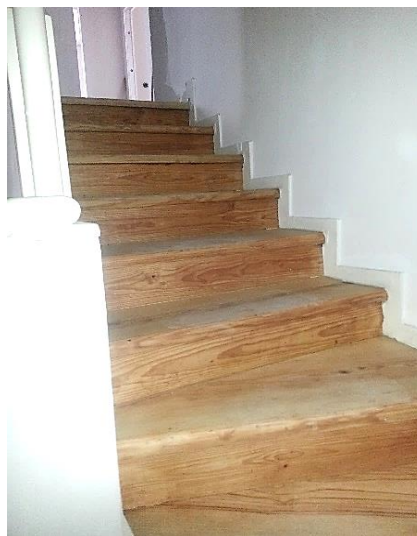
Fig. 3.17 – Escadas interiores (Ligação do Piso 0 ao Piso 1)
