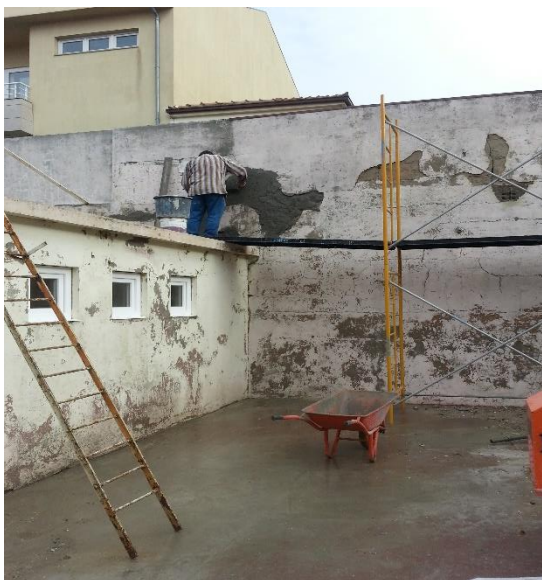
Fig. 3.27 – Execução de trabalhos no muro exterior
