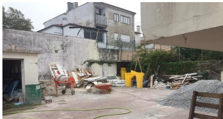
Fig. 3.9 - Vista do logradouro exterior ocupado com materiais e equipamentos de apoio à obra
