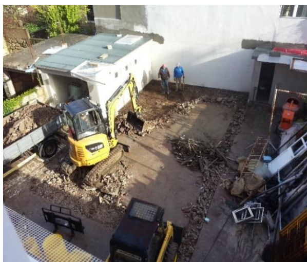
Fig. 3.28 - Demolição do pavimento exterior
