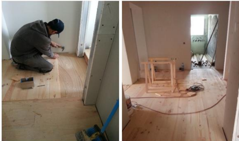
Fig. 3.23 - Colagem do soalho no OSB (Piso 0)
