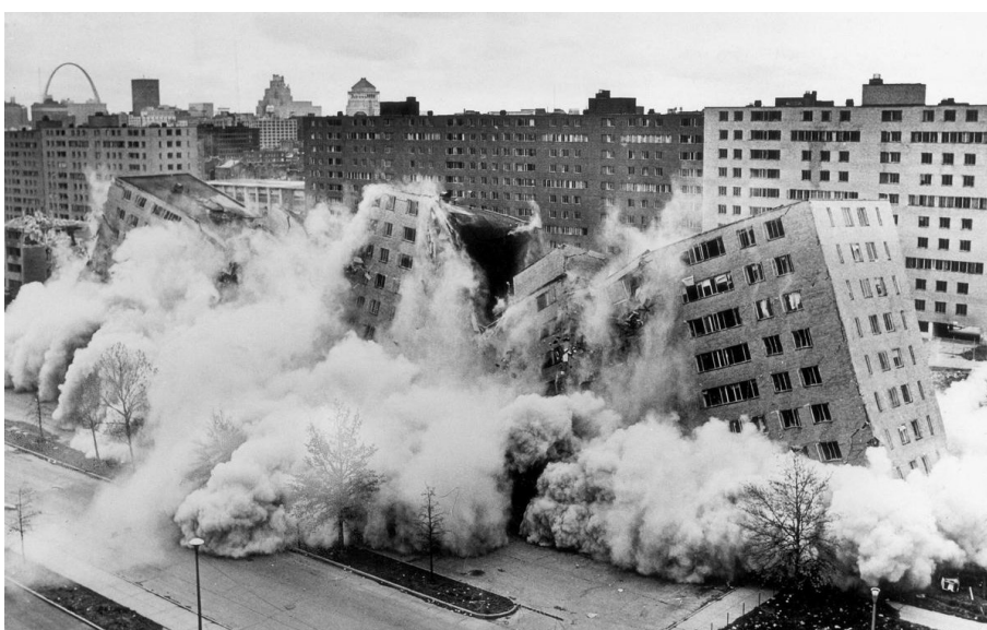
Fig. 96. Demolição de um dos blocos habitacionais que compunha Pruitt-Igoe.
