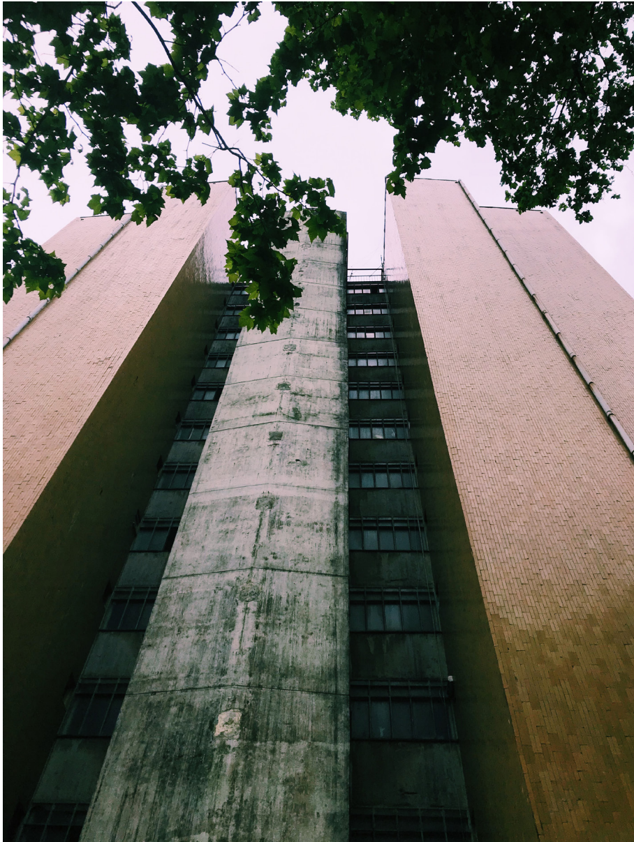
Fig. 71. Torre 3 do Bairro do Aleixo.
