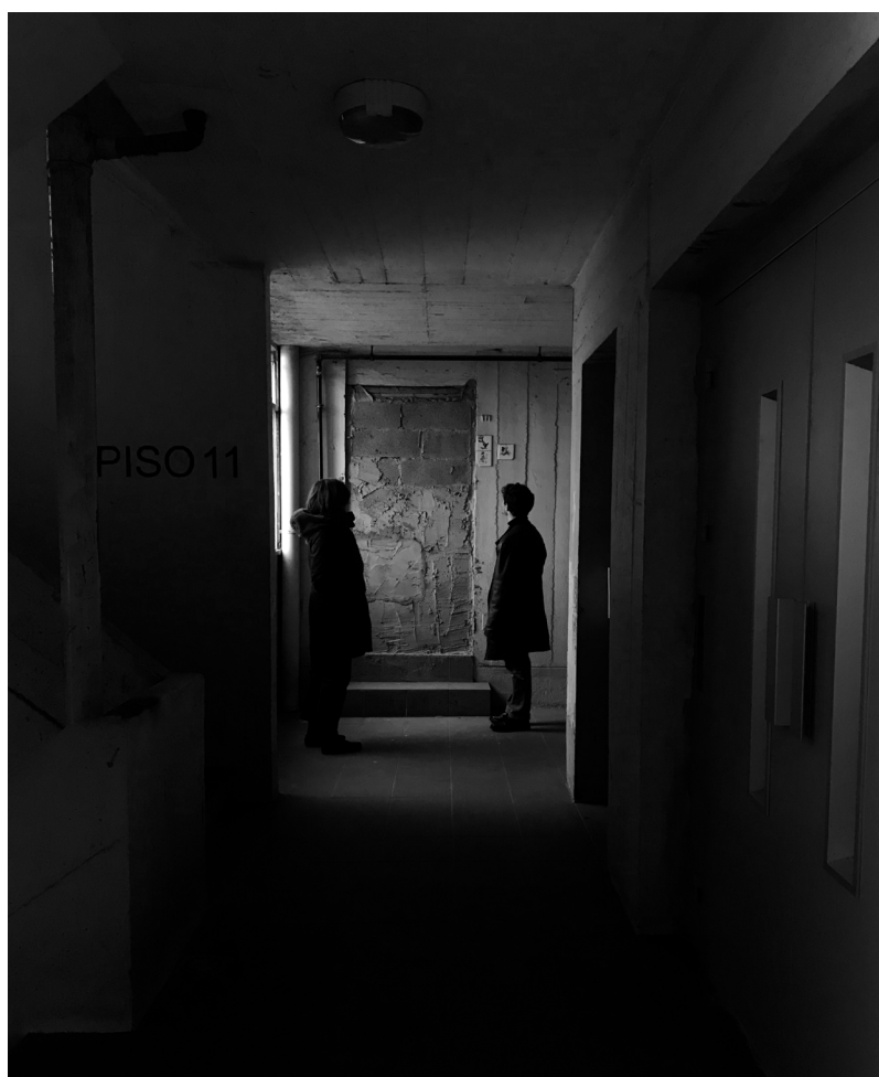
Fig. 104. Galeria de acesso às casas da torre 3 do Bairro do Aleixo, piso 11.
