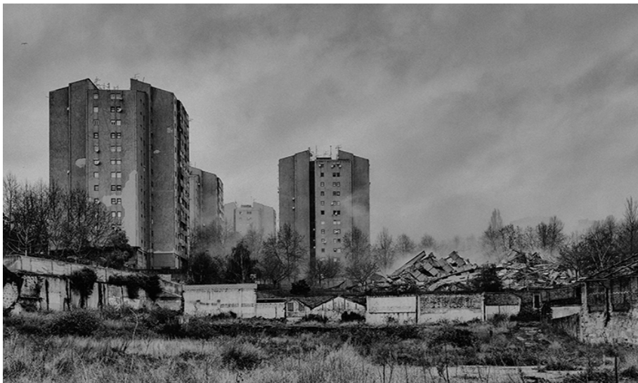
Figs. 75, 76 e 77. Fotografias de vários momentos da demolição da torre 5 do Bairro do Aleixo.
