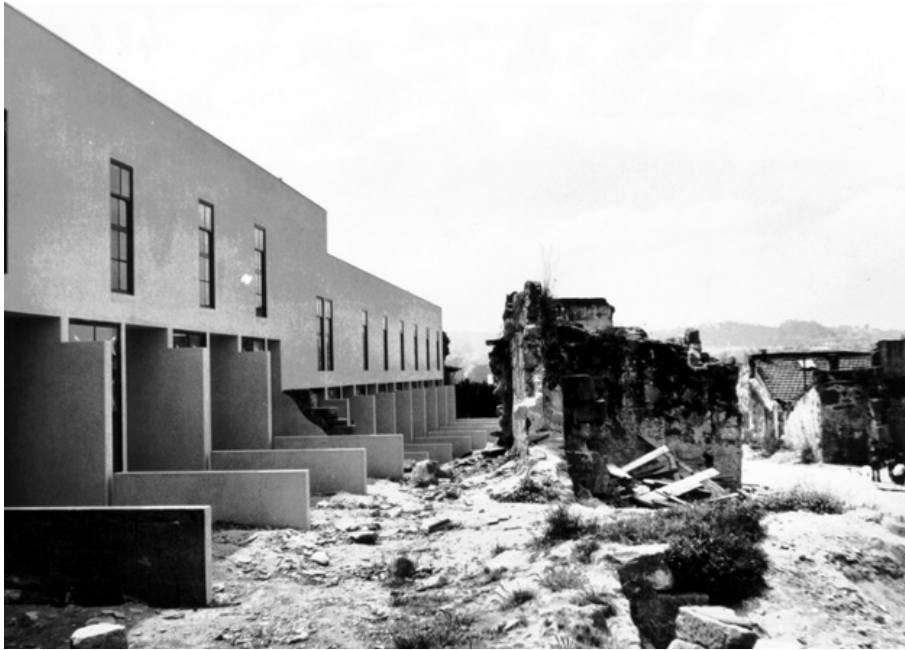
Fig. 33. Bairro de S. Victor em construção, Bonfim, Porto, 1975. Projecto do arquitecto Siza Vieira para habitação económica de promoção pública estatal - FFH (Fundo de Fomento da Habitação) e Operação SAAL.
