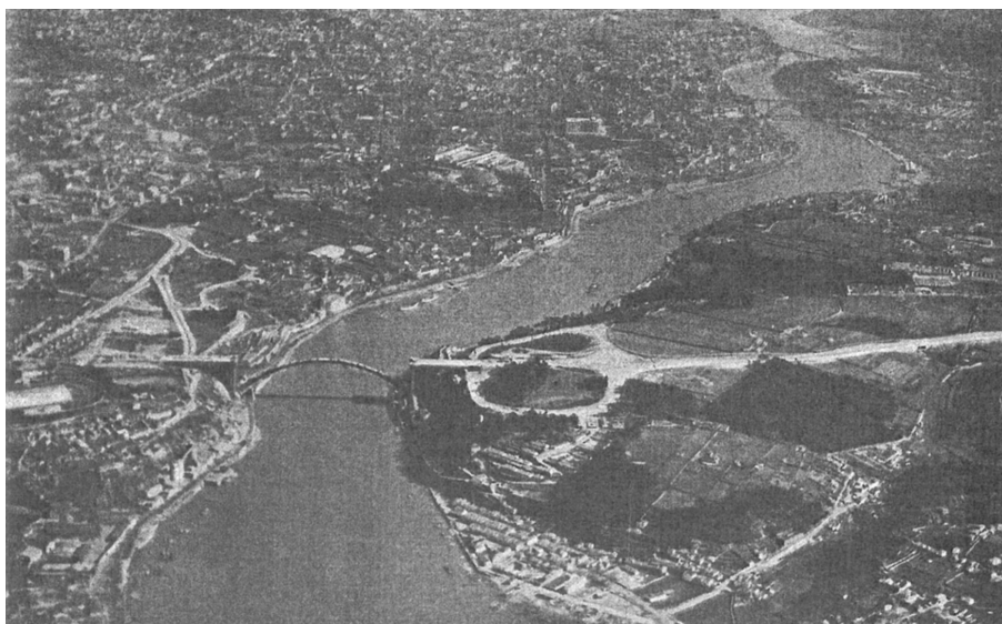
Fig. 26. Construção da Ponte da Arrábida. Possibilitou a ligação entre o Porto e Vila Nova de Gaia e a sua construção trouxe à cidade uma subversão no funcionamento do Porto enquanto centralidade. A Ponte da Arrábida foi inaugurada a 1963.
