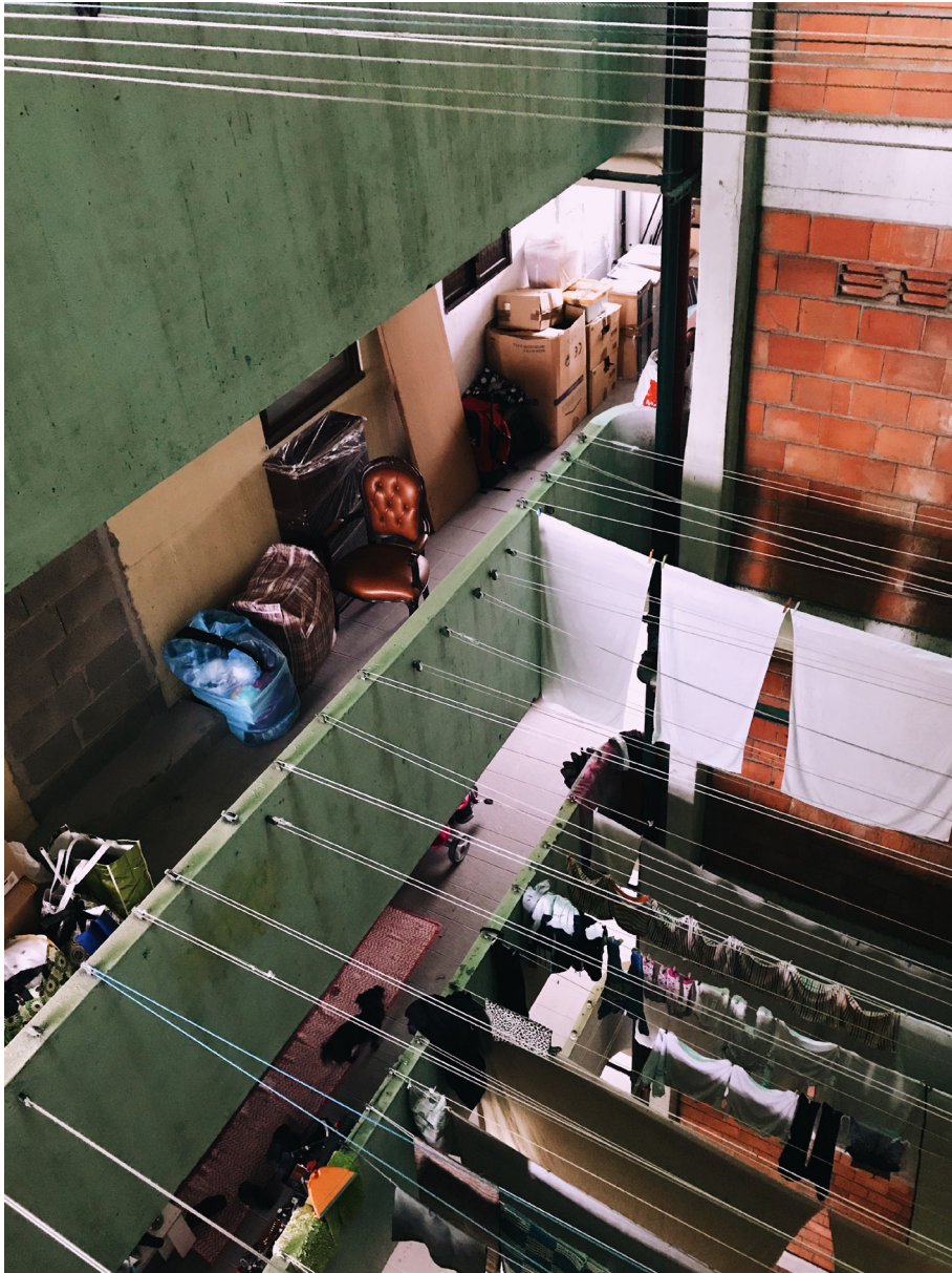
Fig. 201. Fotografia no interior do torre 3 do Bairro do Aleixo, a partir de uma galeria para o saguão.
