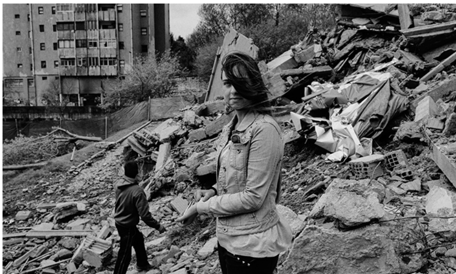
Figs. 78, 79 e 80. Fotografias dos escombros resultantes da demolição da torre 5 do Bairro do Aleixo.
