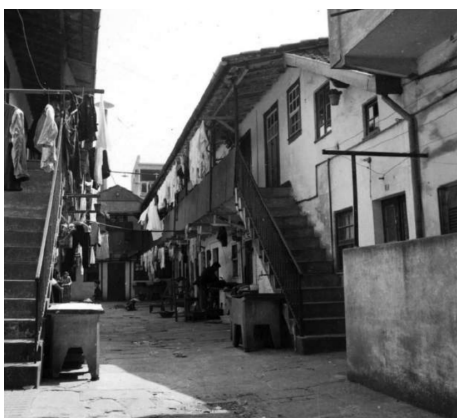
Fig. 15. Ilha do Porto já demolida.
