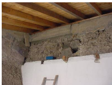
a) Estrutura de cobertura e demolição da laje de esteira
