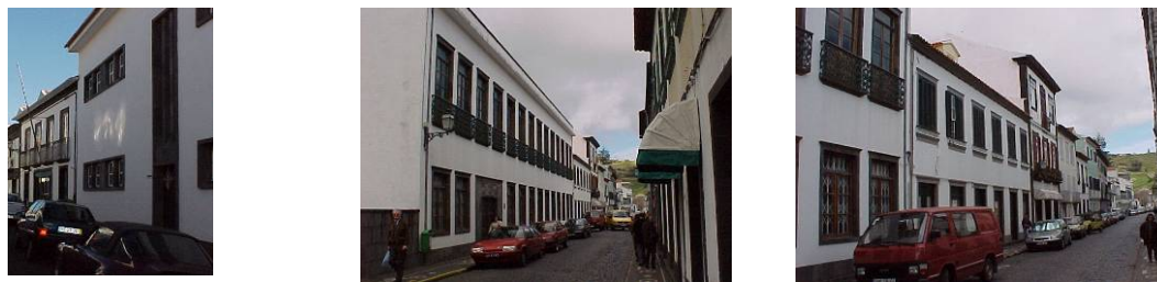
Fig. 6.49- Quarteirão – ligação das estruturas tradicionais ao edifício de betão
