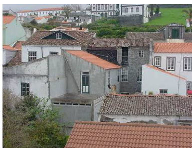
b) Parte de trás da casa nº 15 reboco das paredes
