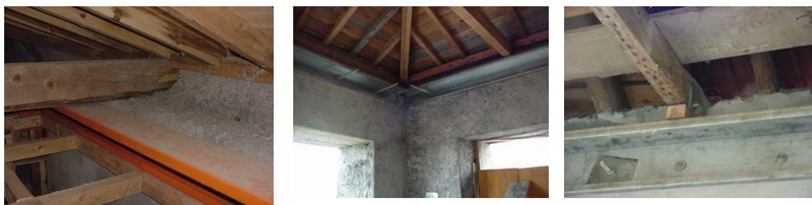
Fig. 6.93 Ligação das cintas à estrutura do telhado
