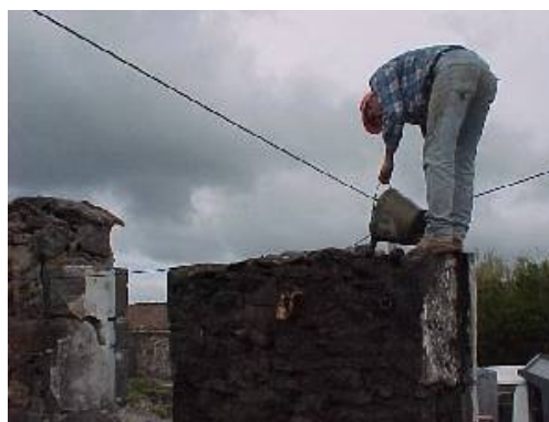
Fig. 4.2 – Introdução da calda na parte de cima da parede
