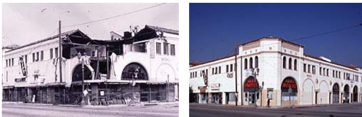
a) Edifício após o sismo
