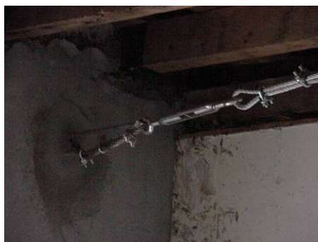
Fig. 6.89– Esquemas de ligação de duas paredes opostas
