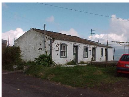
a) Zona Rural; Moradia de piso térreo
