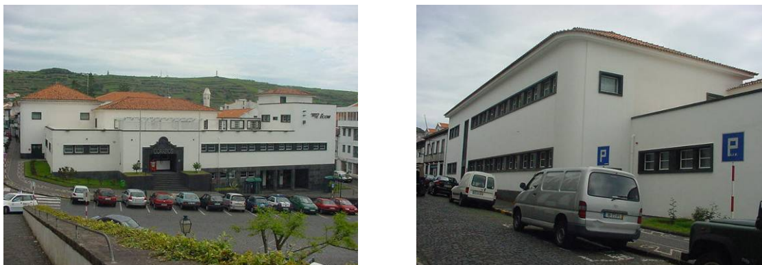
Fig. 2.32 Edifício dos correios – Fachada Principal e Lateral
