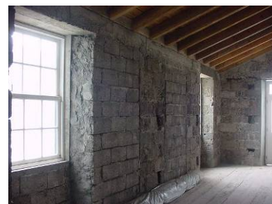
c) Reforço das paredes com lintéis de betão armado
