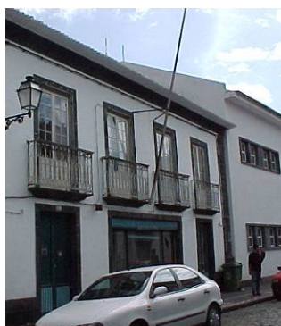
Fig. 2.33 Transição entre o edifício de betão e o edifício em betão armado.
