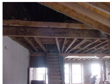
b) Acesso ao piso 2
