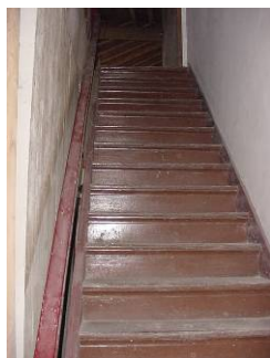
a) Acesso ao piso 1
