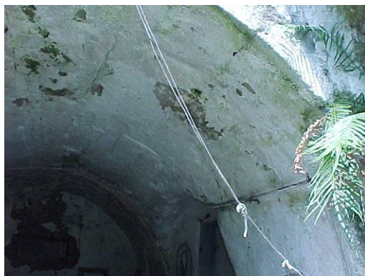
a) Arco em alvenaria de pedra sob a cozinha
