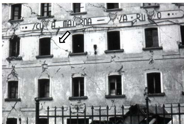
b) Comportamento tipo Esforço Transverso
