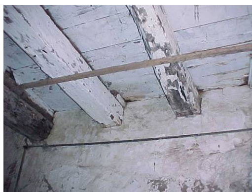
Fig. 2.29 - Casa 24 – Estrutura dos pisos
