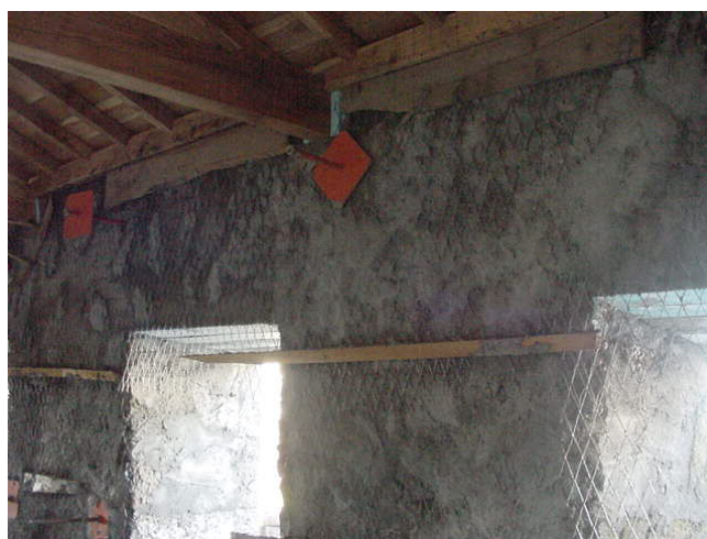
Fig. 6.84— Reabilitação de edifícios na cidade da Horta com reforço das paredes de alvenaria
