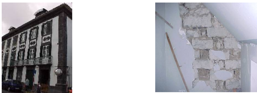
Fig. 2.7 Paredes em zonas urbanas com boa qualidade
