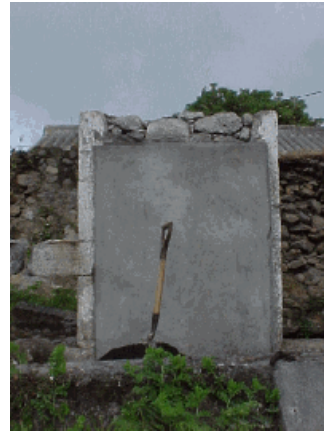
Fig. 4.4 – Parede reforçada com malha (A2)
