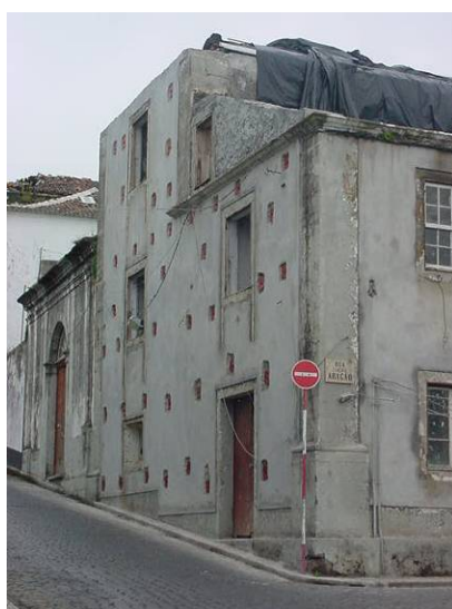
Fig. 6.84— Reabilitação de edifícios na cidade da Horta com reforço das paredes de alvenaria
