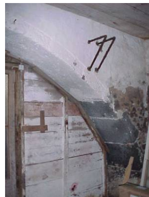
b) Arco em alvenaria de pedra na parede mestra interior
