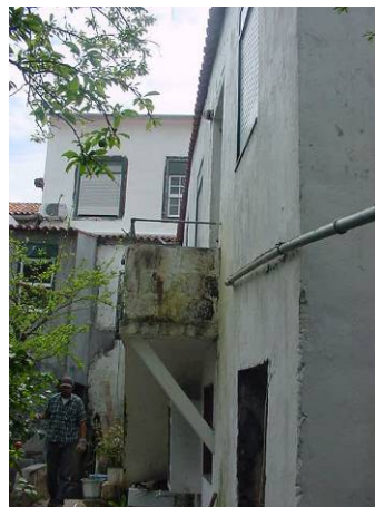
Fig. 2.11 Ampliações e reconstruções executadas em estrutura de betão armado e laje de vigotas
