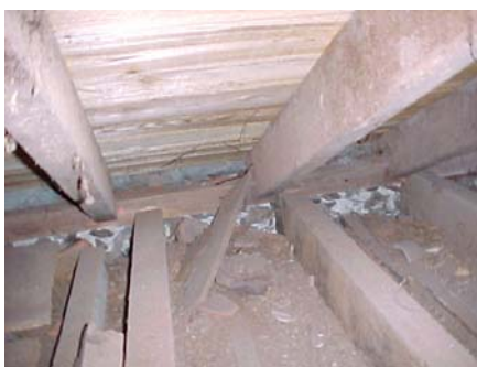
Fig. 2.9 Ligação da cobertura ao freixal
