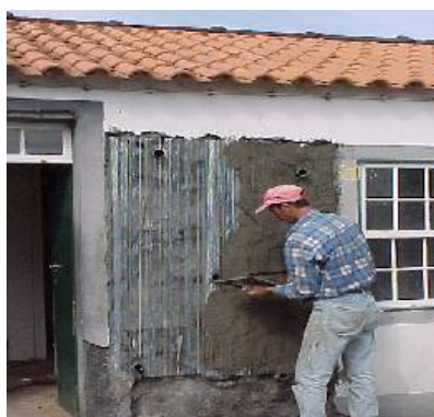
Fig. 4.1 – Operação de reboco da parede por cima da malha de aço
