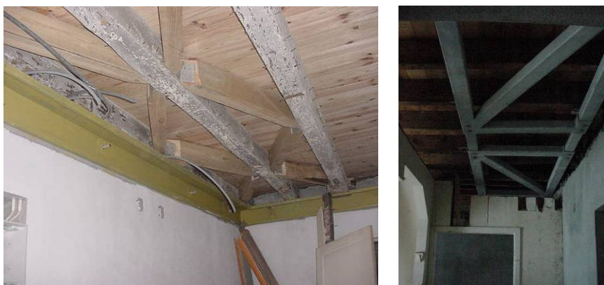
Fig. 6.88– Esquemas de travamento das empenas ao nível dos pisos
