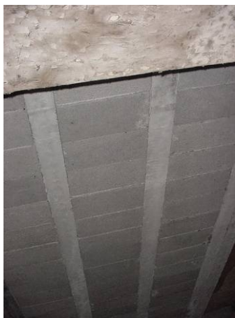
Fig. 2.11 Ampliações e reconstruções executadas em estrutura de betão armado e laje de vigotas
