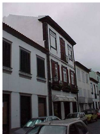
b) Casa 16; Fachada principal
