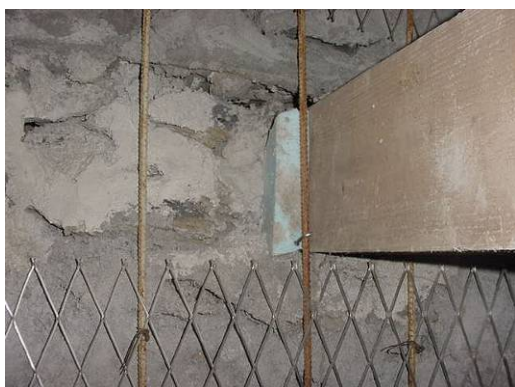
a) Empalme da malha de aço com perfis na zona dos pavimentos.
