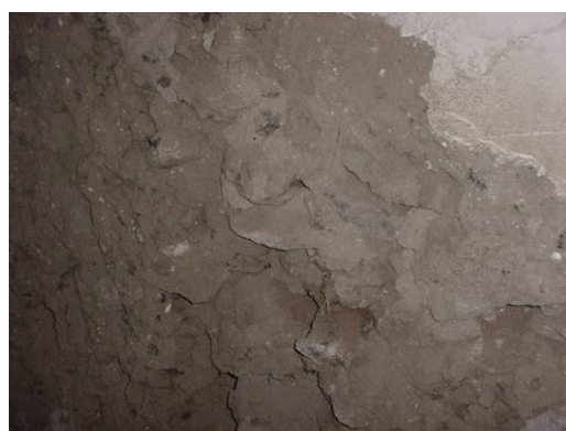
b) Parede com má qualidade
