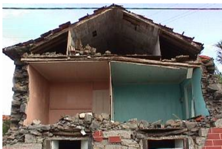
Fig. 2.5 Divisórias interiores em tabique
