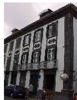
c) Zona Urbana; Edifício na cidade da Horta
