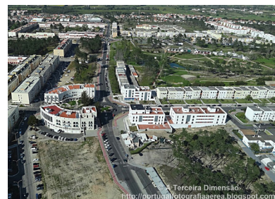
Figura 14 - Avenida de Sines.
