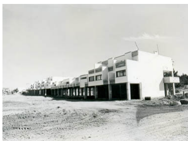
Figura 17 - Bairro Atalaia Sul, aquando a sua construção.
