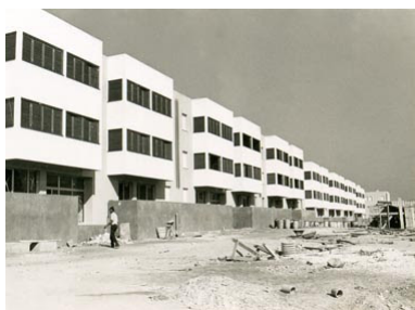
Figura 53 - Bairro do Liceu, aquando a sua construção.
