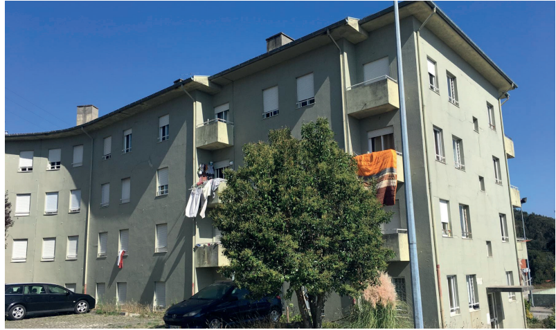
Figura 38: Bairro da Outrela Topo do maior Bloco Habitacional
