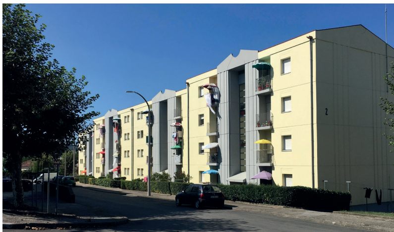
Figura 35: Bairro do Calvário Fachada de Bloco habitacional
