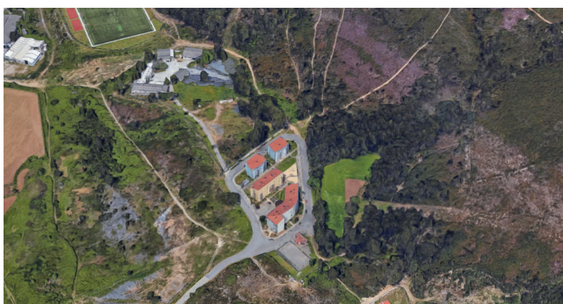
Figura 34: Vista aérea do Bairro da Outrela e sua envolvente. Onde se pode verificar o seu isolamento em relação à envolvente.
