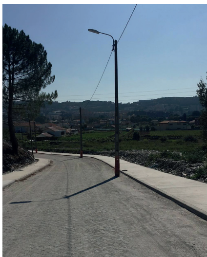
Figura 42: Estrada de acesso ao Bairro da Outrela recentemente intervencionada
