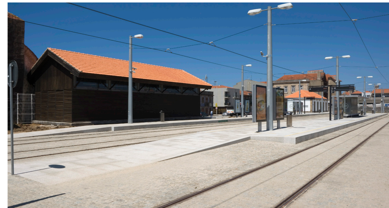
126. Edifício para funcionários e maquinistas e à direita na imagem, o abrigo na ilha central
