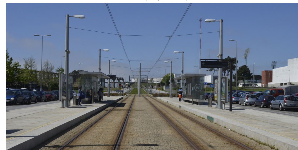
1099. Estação Vila do Conde
