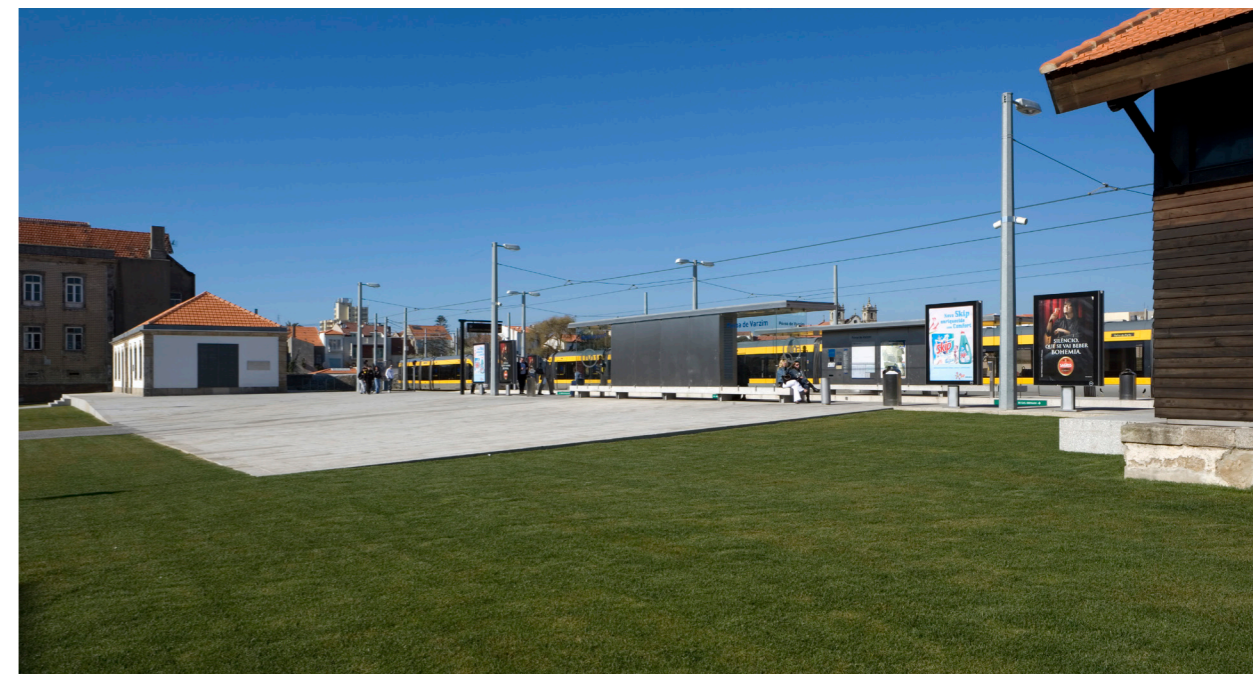
1128. Relação entre os dois edifícios recuperados, a plataforma de granito e a relva, a olhar para norte
