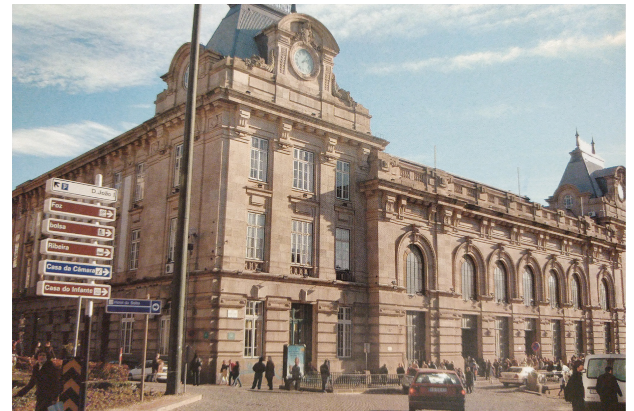
1034. São Bento antes do Metro
