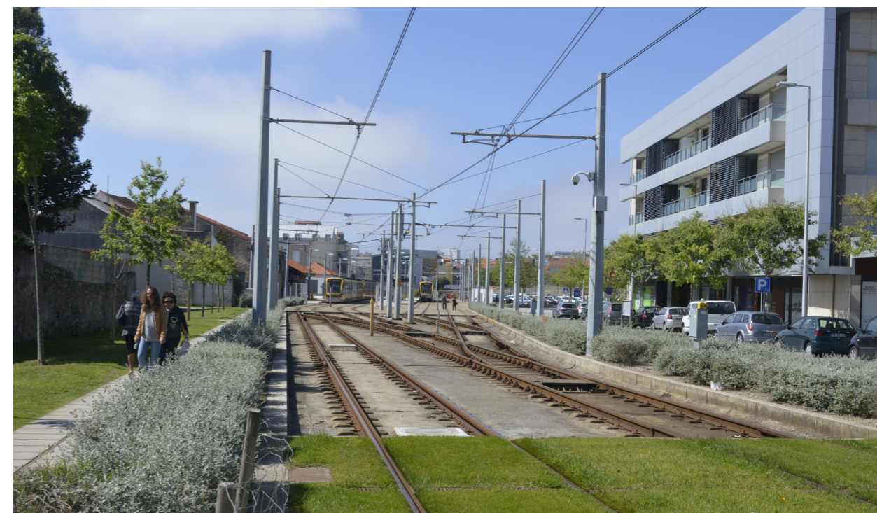
1122. Duplicação da parrelha de carris e parafernália infraestrutural
