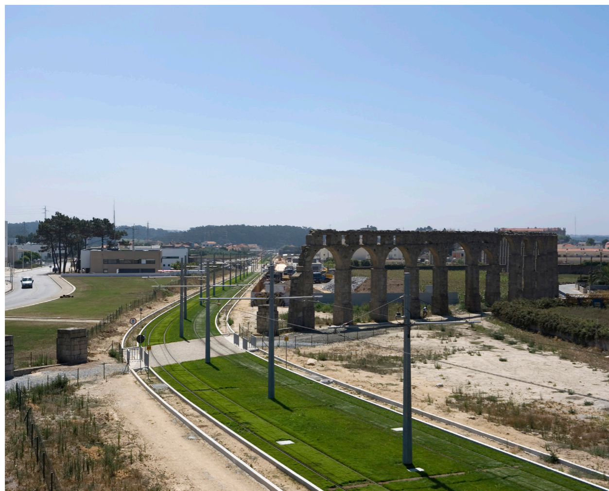
1083. Linha ainda em construção a atravessar o Aqueduto de Santa Clara
