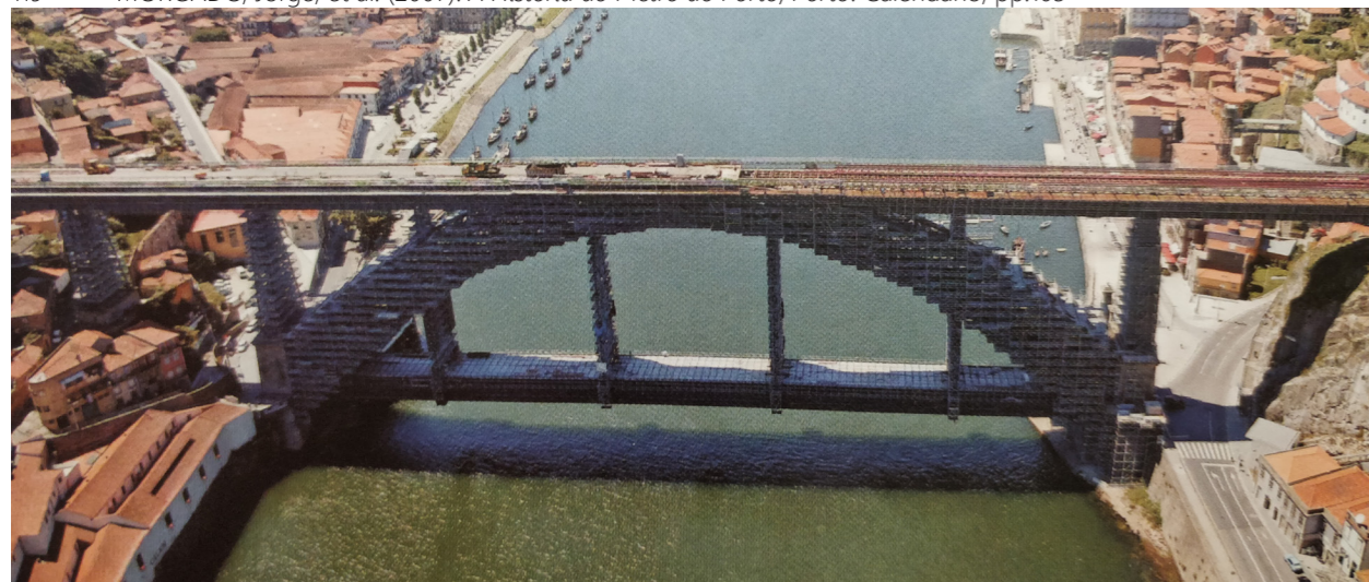
1042. Ponte Luiz I envolta em andaimes
