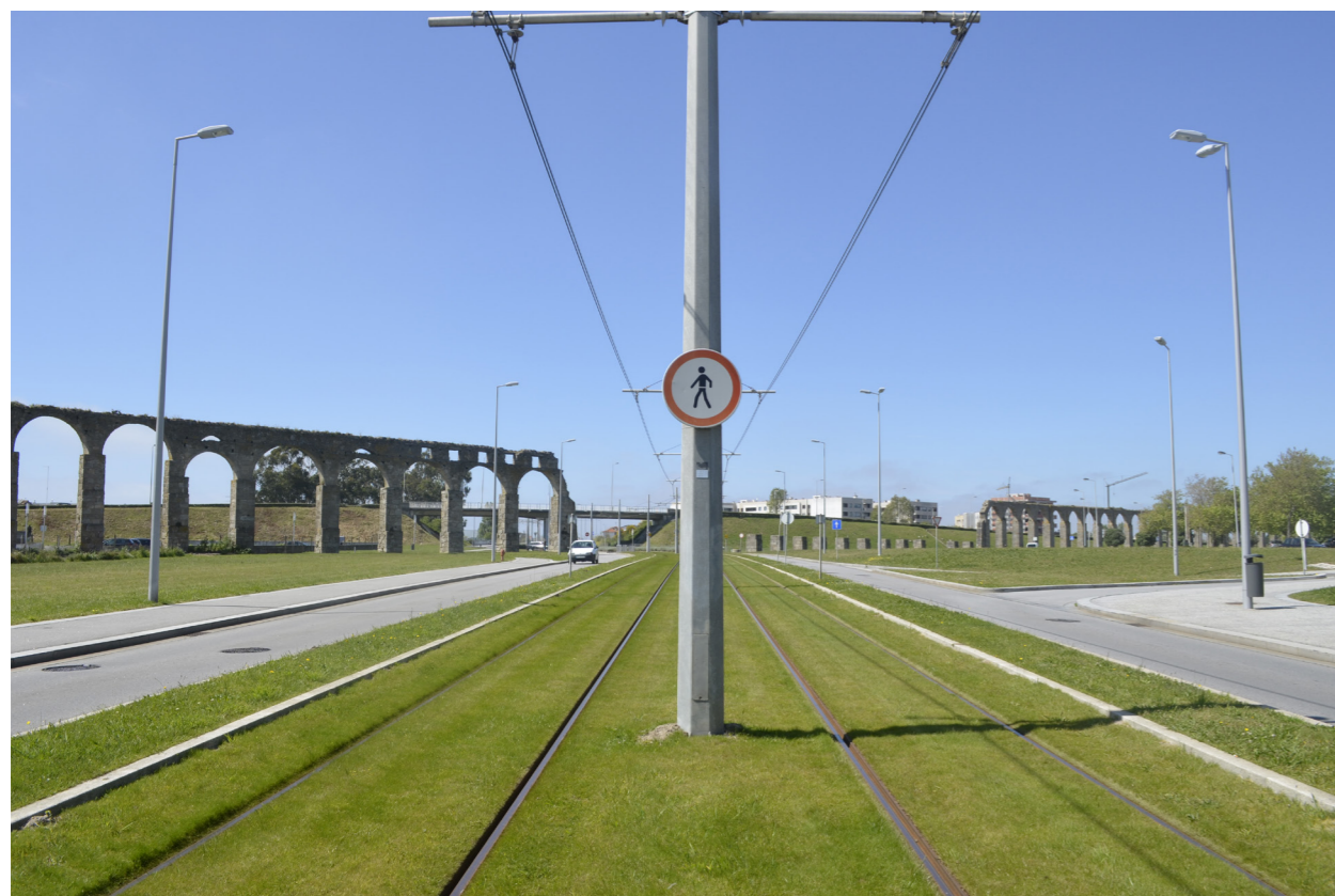
1101. Aproximação ao Aqueduto e mar de verde
