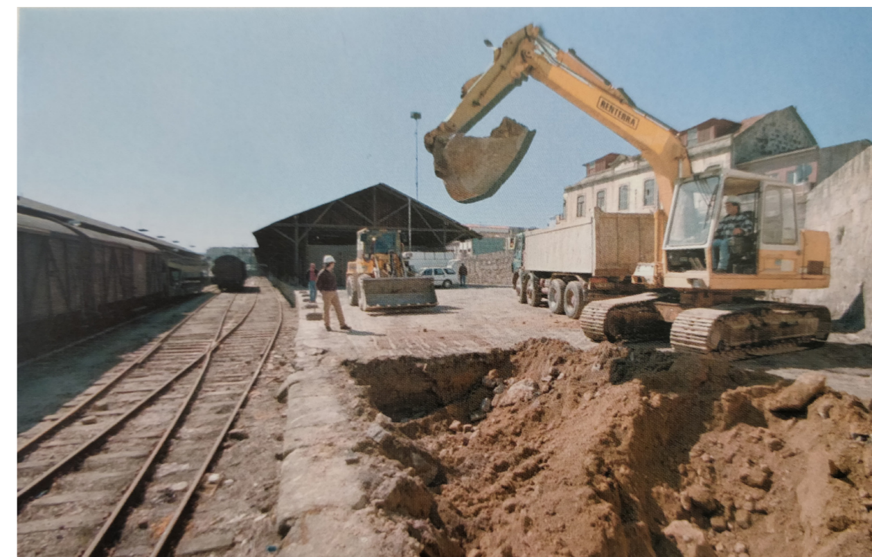
1038. Início das obras
