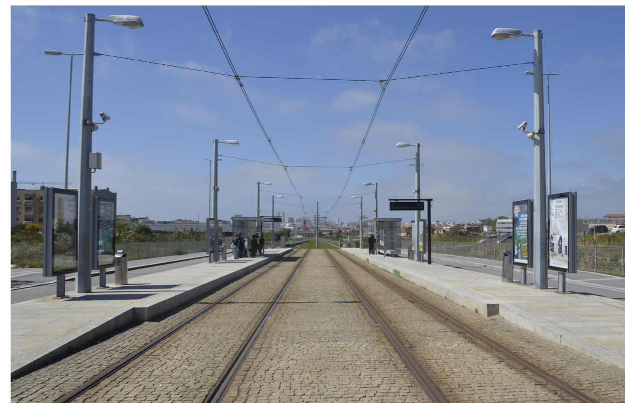
1109. Estação Portas Fronhas
