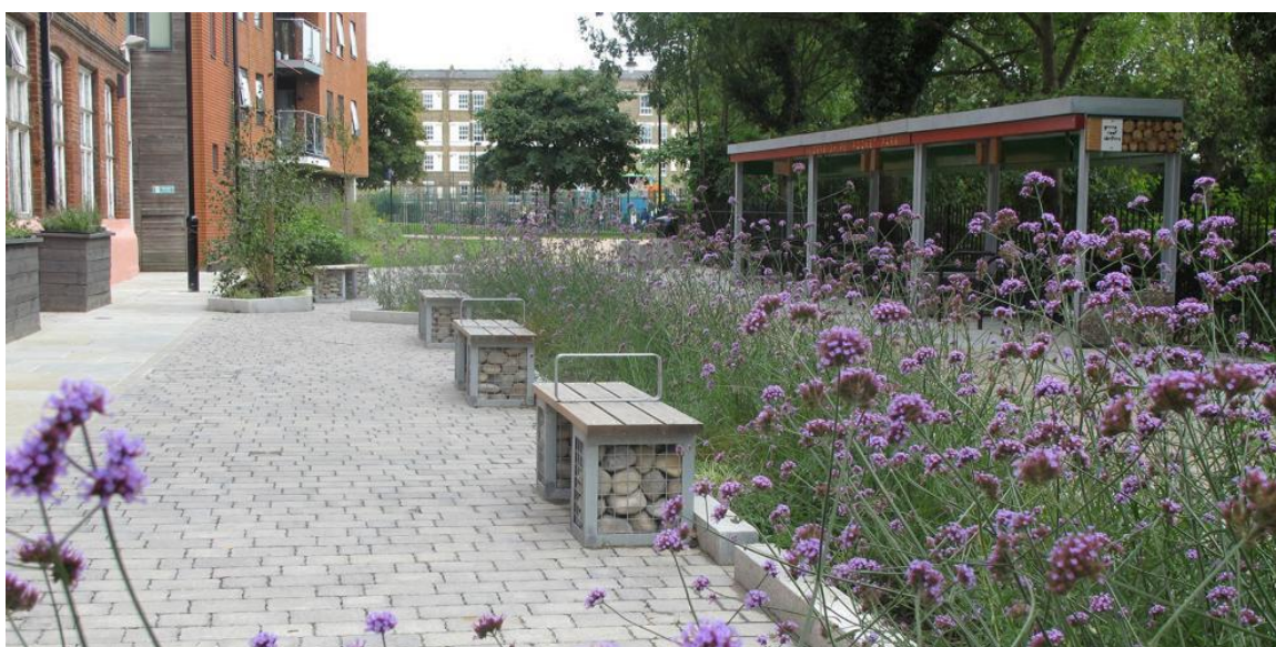
Figura 17 - Fotografia de uma vala de infiltração Derbyshire Street pocket park. Fonte: London.gov
