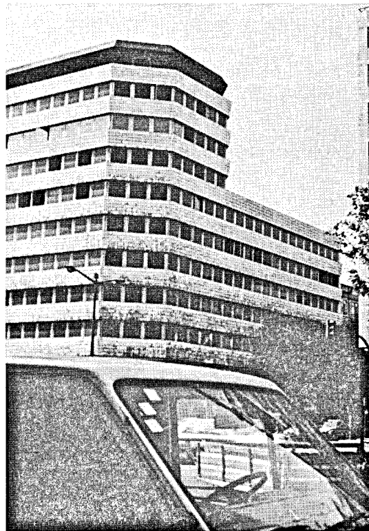
Figura 2.2: Edifício com irregularidade em altura.
