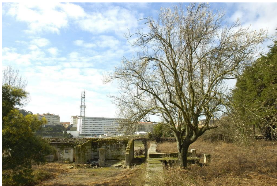
Figura 11 - Vista parcial dos anexos da Quinta de Salgueiros. Fonte: http://manueljosecunha.blogspot.com/2018/03/quinta-de-salgueiros-porto.html
