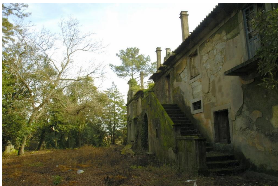
Figura 10 - Vista parcial da fachada da Casa da Quinta de Salgueiros. Fonte: https://dias-com-arvores.blogspot.com/search?q=quinta+de+salgueiros
