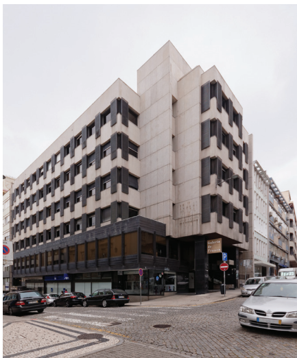
Edifício Galeria de França (AXA-UAP), Porto Arqs. Pádua Ramos, José Carlos Loureiro, 1971 © Carlos Albuquerque Castro
