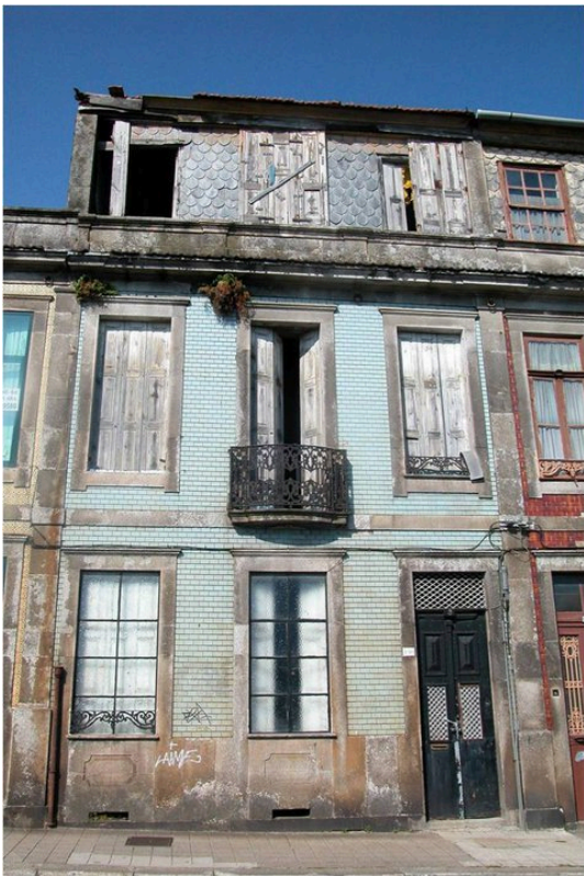
Fig. 68 | Casa Cristina Silva Fachada principal antes da intervenção
