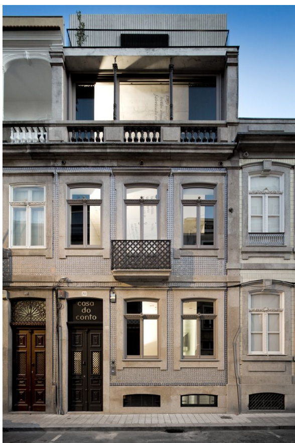
Fig. 48 | Casa do Conto , Pedra Líquida | Porto Um exemplo que se afasta da prática do fachadismo e que mantém com uma profunda sensibilidade as principais características do preexistente, através de uma intervenção contemporânea.
