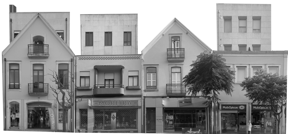
Fig. 50 | Fachadismo | Edifícios de análise | Rua 19, Espinho
