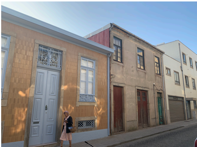
Fig. 28 | Levantamento fotográfico | Rua 12 | S-N
