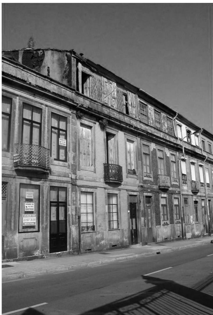
Fig. 59 | Casa Cristina Silva | Fachada principal antes da intervenção
