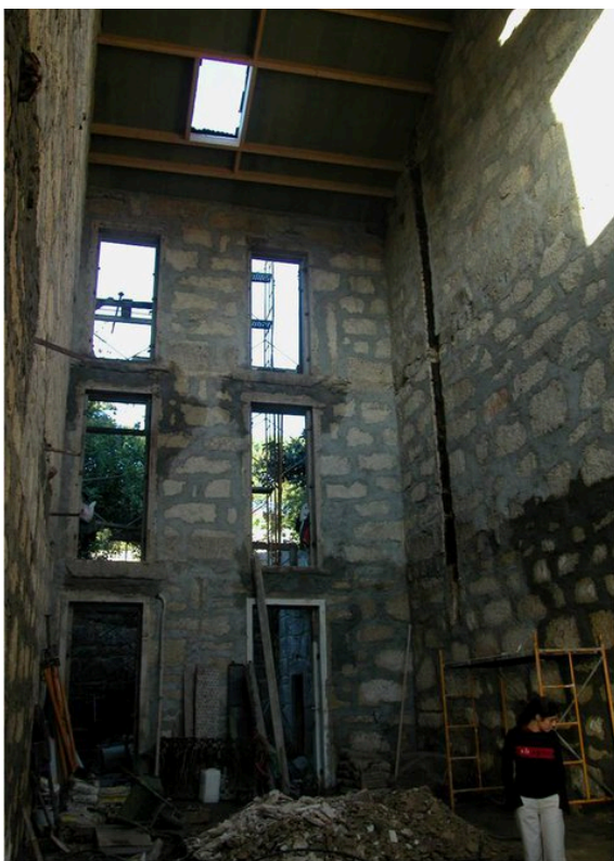
Fig. 63 | Casa Cristina Silva | Vista da obra
