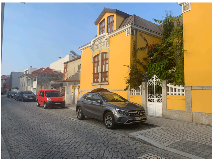
Fig. 35 | Levantamento fotográfico | Rua 10 | S-N
