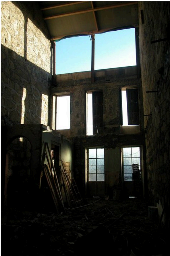
Fig. 62 | Casa Cristina Silva | Vista da obra
