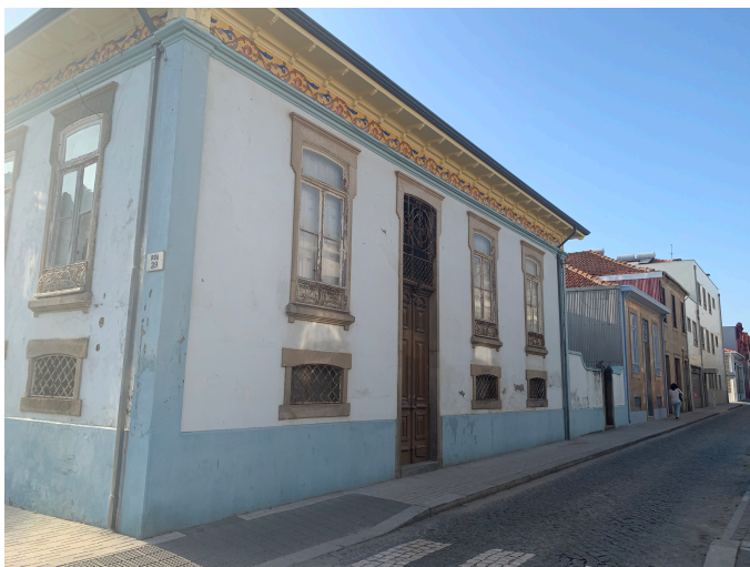
Fig. 27 | Levantamento fotográfico | Rua 12 | S-N
