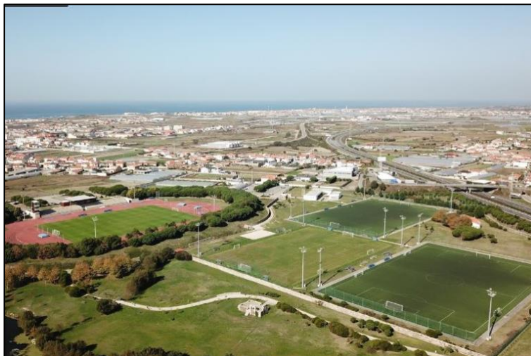
Figura 6: Complexo Desportivo Municipal. Retirado de cm-pvarzim.pt em Julho de 2018
