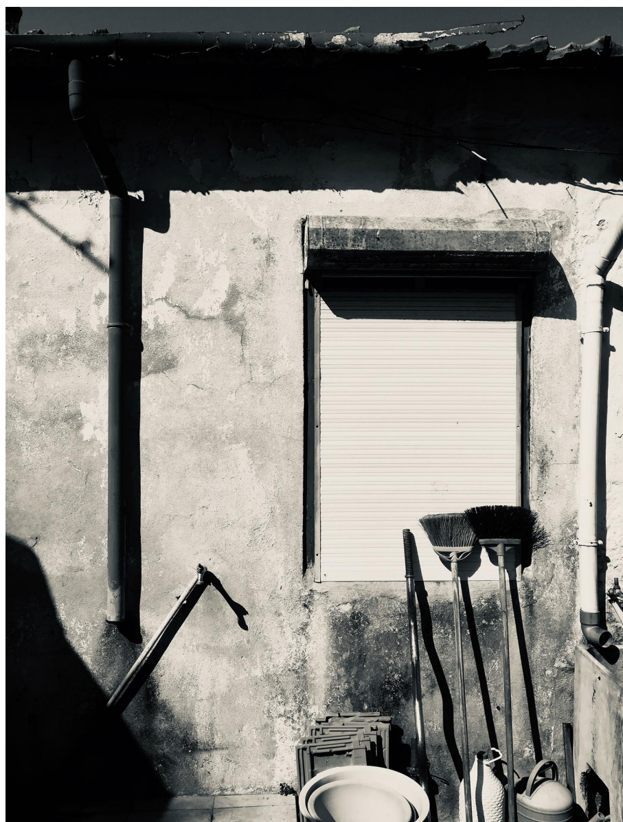
[Fig. 73] Fotografia da janela da casa n.º10, Ilha 23A, 2018
