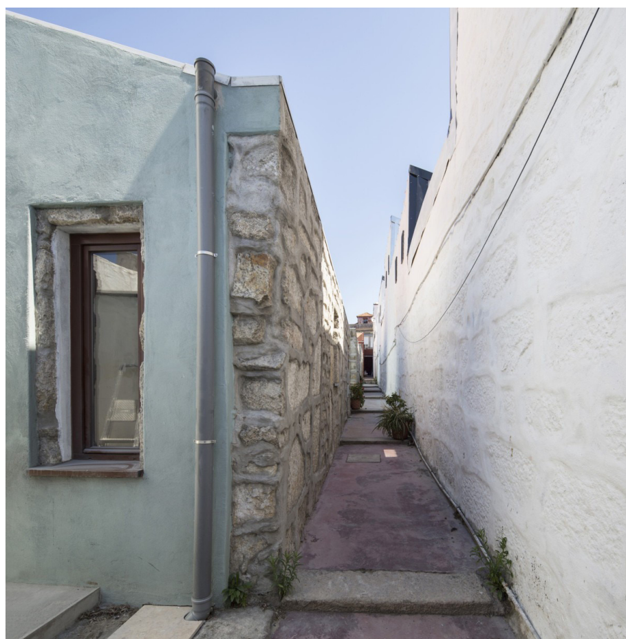
[Fig. 41] Fotografia do corredor de acesso, após intervenção
