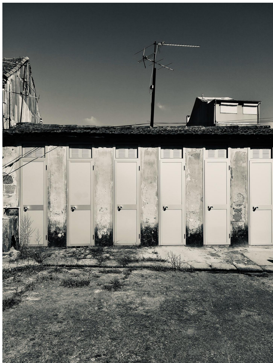
[Fig. 97] Fotografia do núcleo das instalações sanitárias na Ilha 23A, 2018
