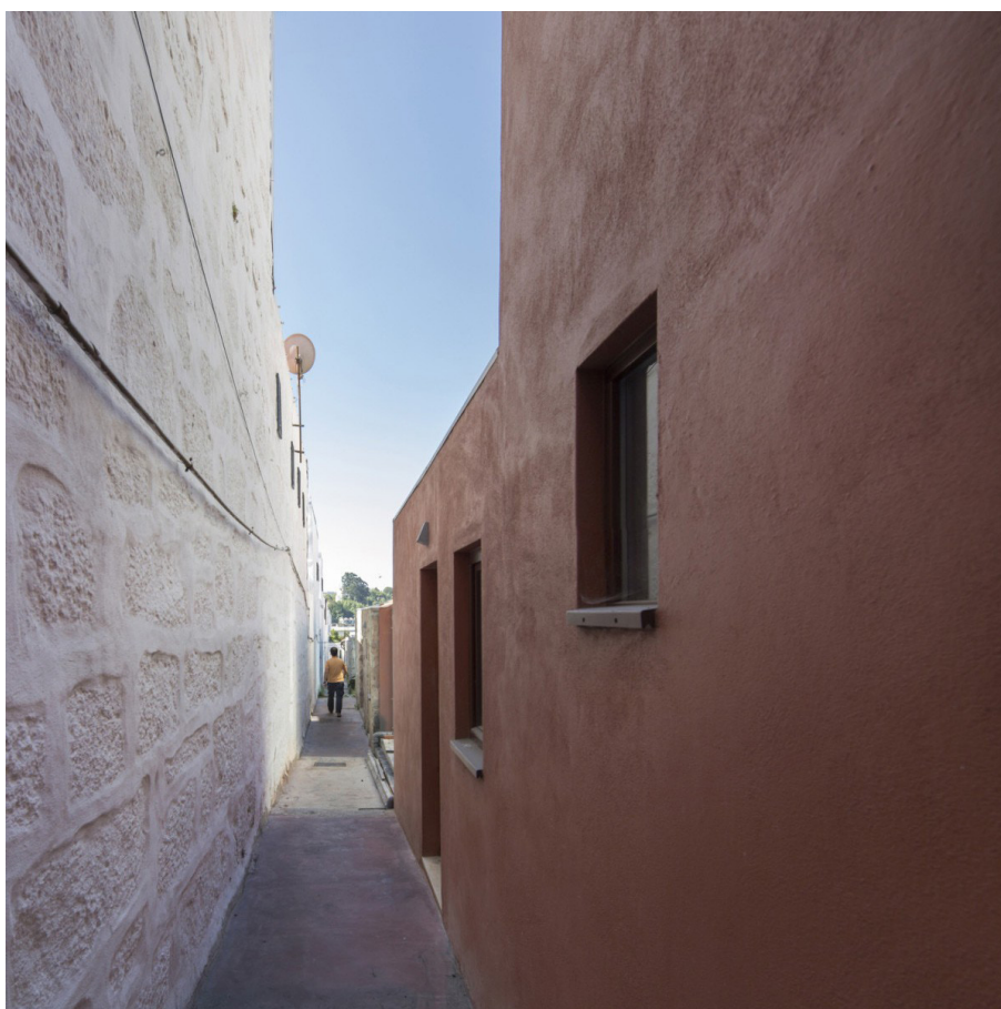
[Fig. 42] Fotografia do corredor de acesso, após intervenção
