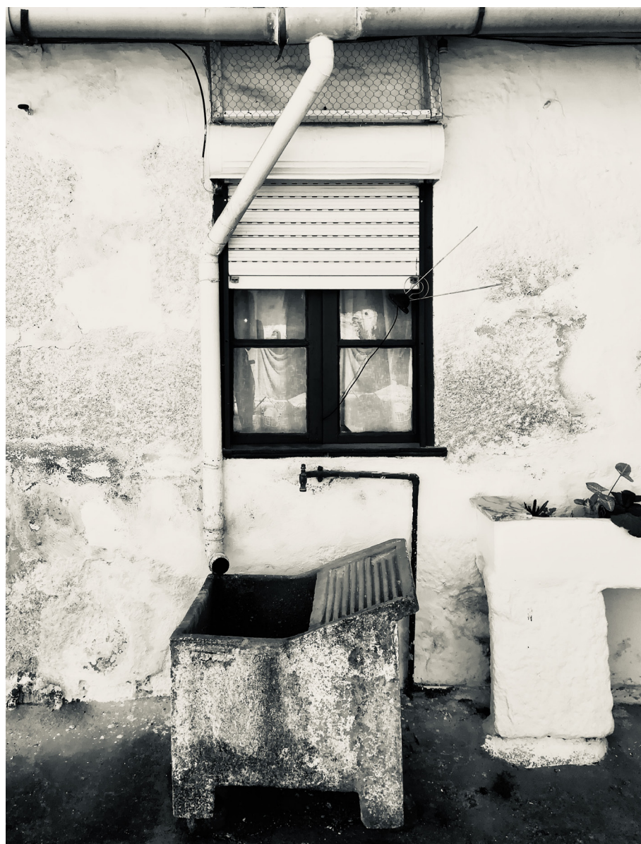
[Fig. 72] Fotografia da janela da casa n.º 6, Ilha 23A, 2018
