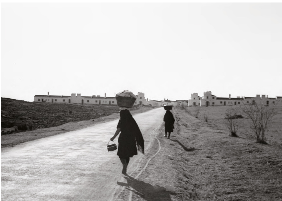
[Fig. 7] Fotografia do Bairro de Casas para famílias pobres em Aldeia Nova de São Bento (1948-1953), do arquiteto Leonardo de Castro Freire)
