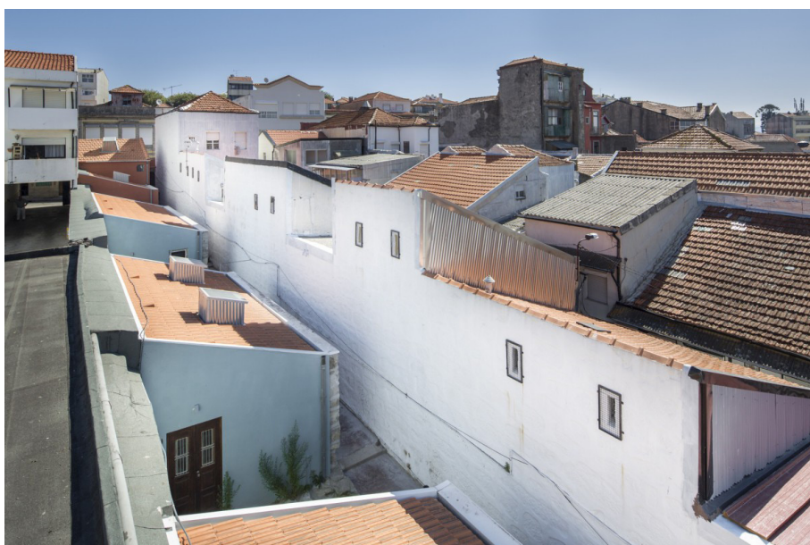
[Fig. 40] Fotografia geral da ilha, após intervenção
