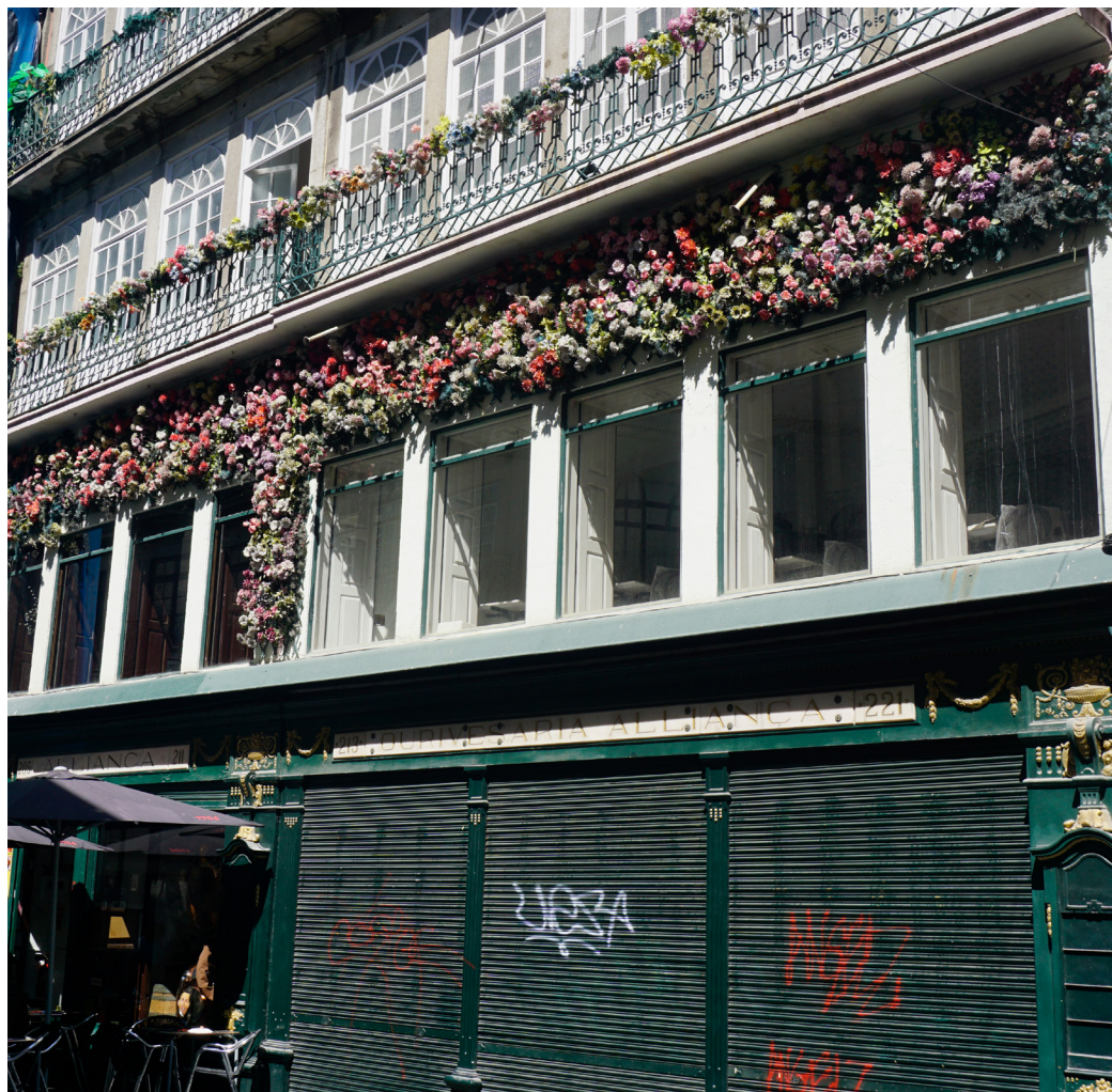
FIGURA 62 A 64. AS FASES DA FACHADA.
