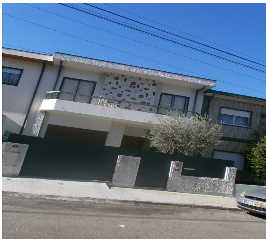
Figura 2 – rua das Saibreiras – outubro, 2018 – fotografia PA090313 JPG – autor: Lurdes Gomes
