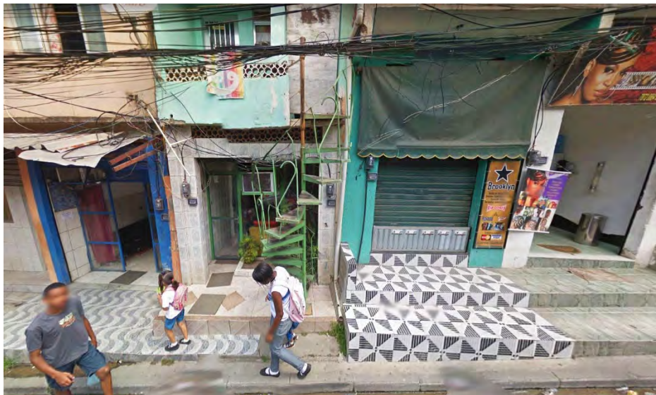
Figura 85: Variação da pavimentação na Rua Antônio Austregésilo.
