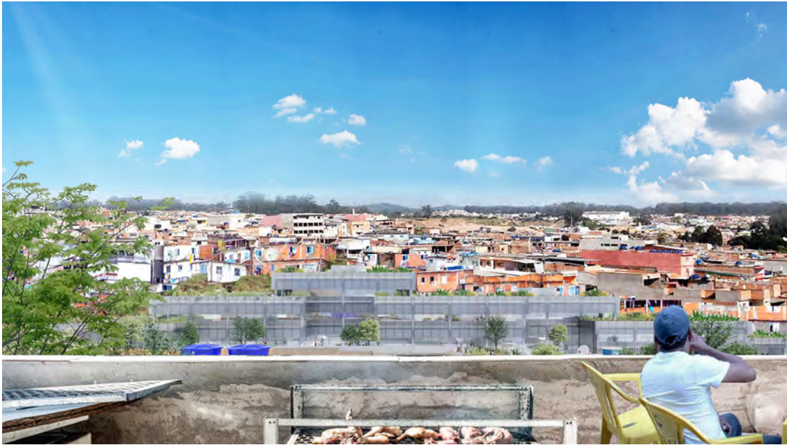
Figura 127: Vista frontal do edifício.
