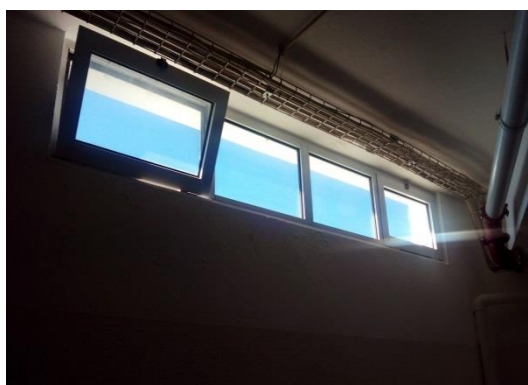
Foto 10: Vão env. giratório – cx. metálica + vidro duplo incolor sem proteção solar
