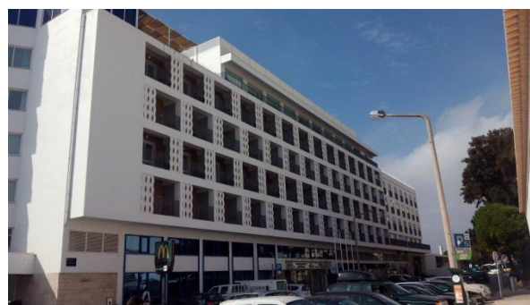
(d) Fachada a nordeste (Quartos Cidade)
