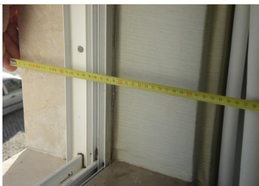
Foto 13: Verificação da espessura da envolvente opaca exterior (Pext1)
