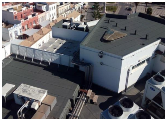
Foto 2: Cobertura exterior do edifício
