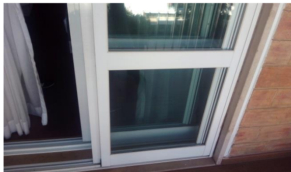
(b) Vãos duplo com vidro duplo incolor. Proteção solar interior através de cortina transparente de cor clara, pelo interior, seguida de uma cortina opaca também de cor clara.
