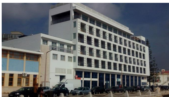
(c) Fachada a sudeste (Quartos Marina)
