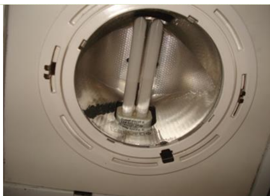
Foto 14: Iluminação fluorescente compacta não integrada
