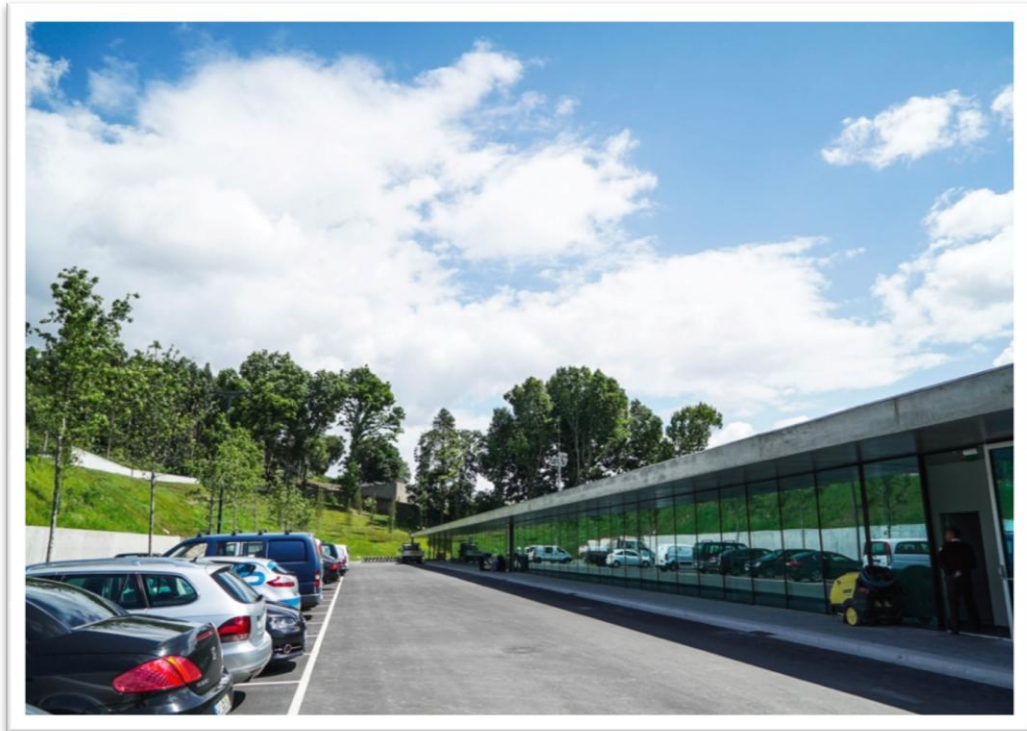
Figura 30 Zona Exterior, Piso 3 CD, Foto SCB
