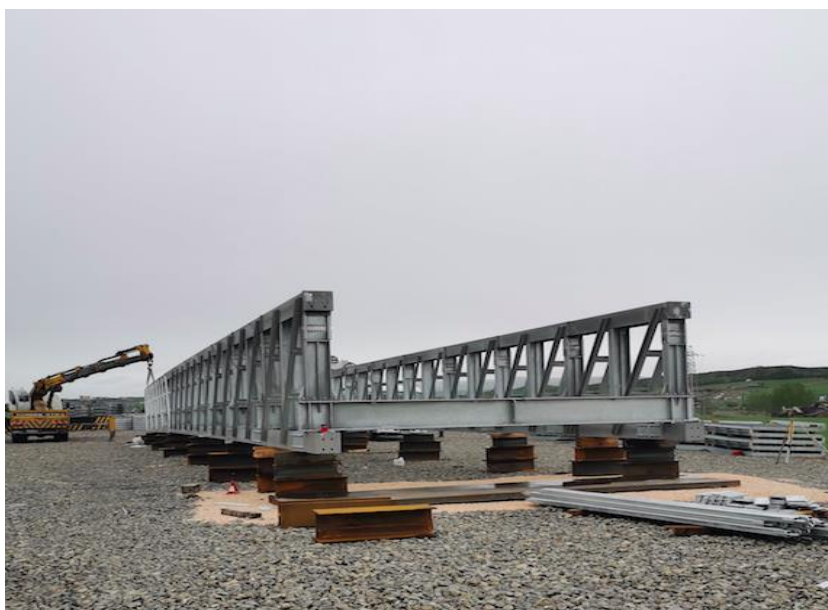
Figura 4.6 - Vista da ponte MB36 após pré-montagem em fábrica.
