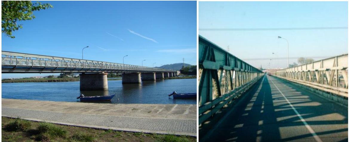
Figura 2.18 - Ponte treliçada metálica do tipo “Half-Through”. Esposende - Fão, Portugal.
