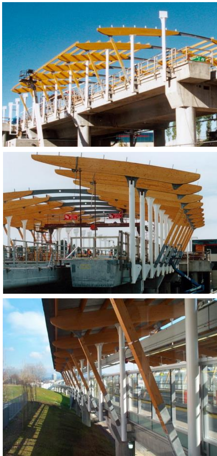
Figura 2.25 - Estrutura mista aço-madeira- Pilares em aço, vigas e contraventamentos em madeira, - Rupert Station – Vancouver, British Colombia, Canada. [16]
