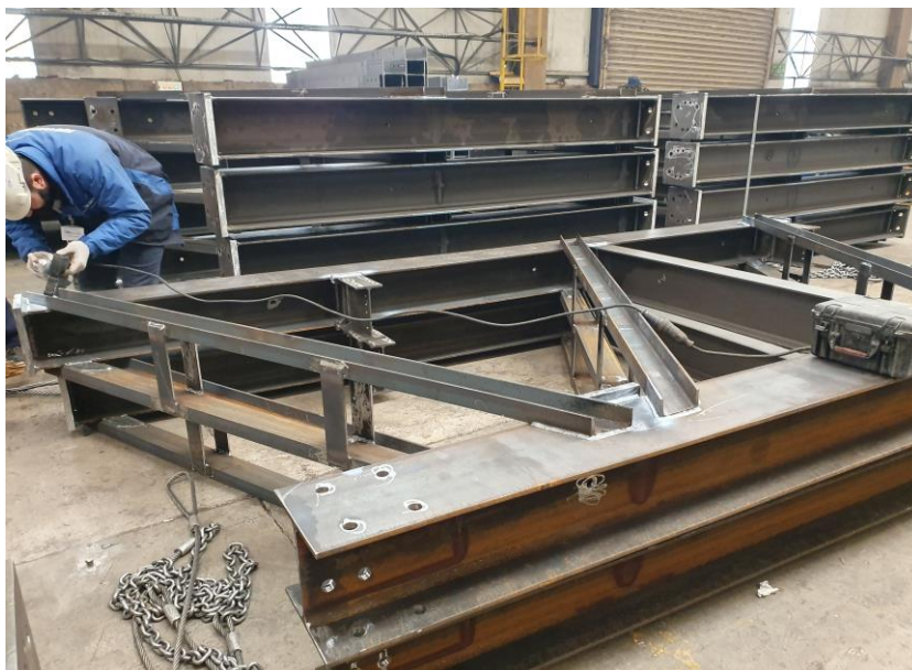
Figura 4.3 - Inspeção de soldaduras.
