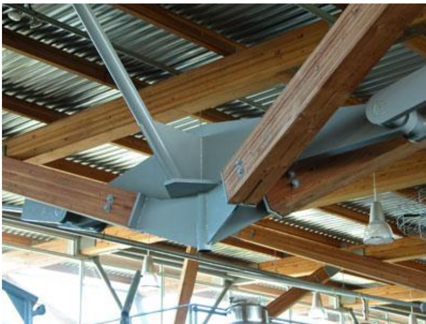
Figura 2.27 - Pormenor de ligação de uma treliça mista.[15]
