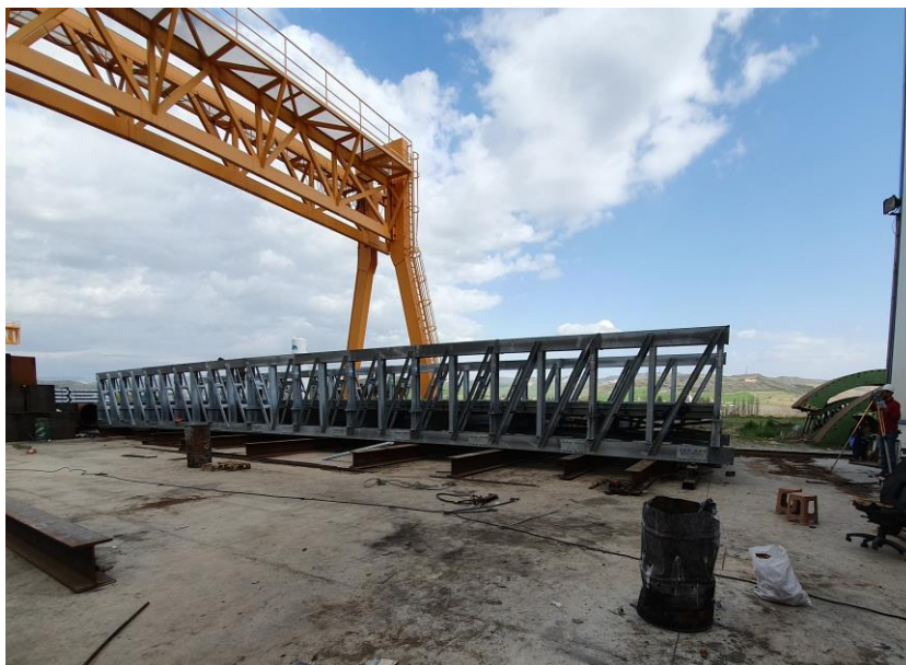
Figura 4.5 - Pré-montagem da ponte MB36 em fábrica.
