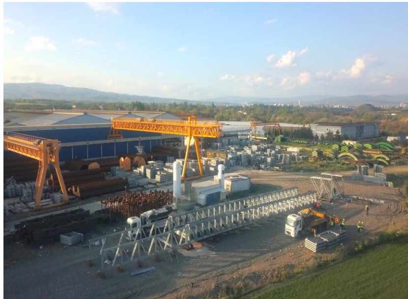
Figura 4.10 - Pré-montagem da ponte MB36 e do nariz de lançamento.
