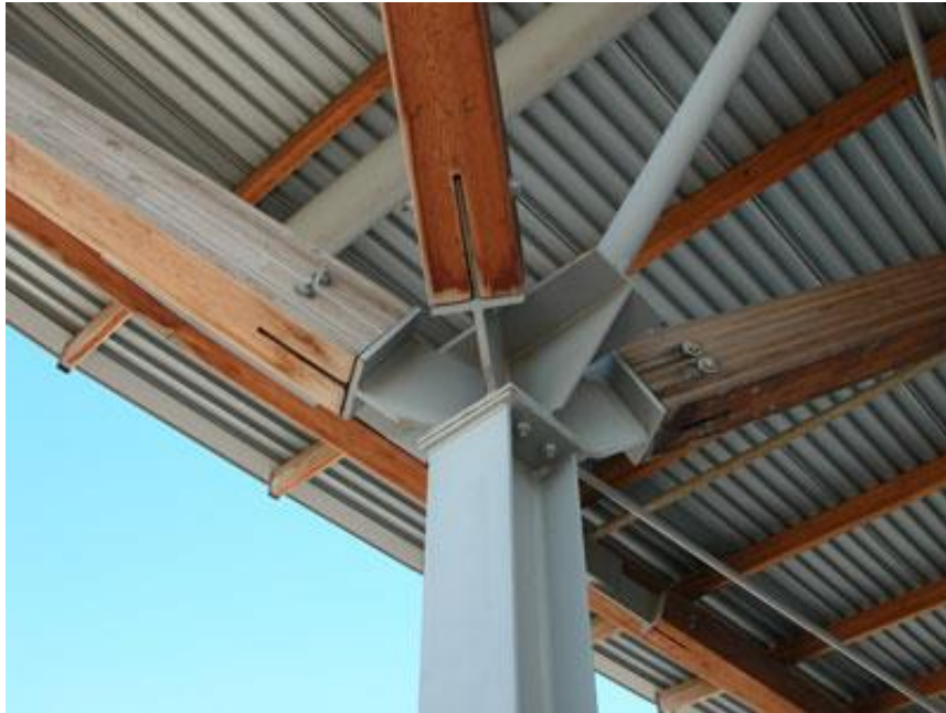
Figura 2.26 - Pormenor de ligação de uma treliça mista.[15]
