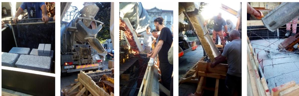
Fig. 87. Processo de enchimento da sapata em betão, av. Central, Braga.
