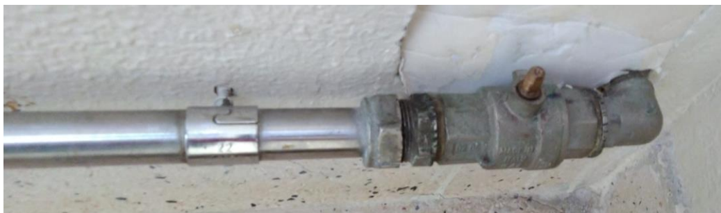
Figura 59 - Adufa sem selagem viável
