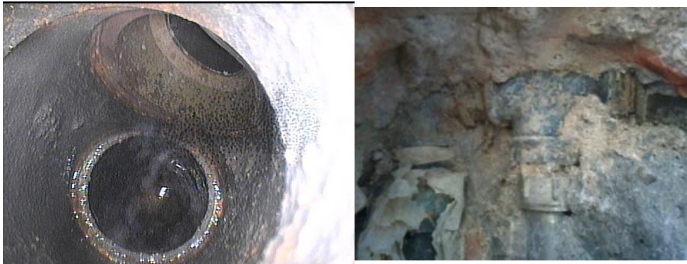
Figura 26 - Consumo ilícito detetado (“t”) identificado através de videoscopia (APDA 2017)
