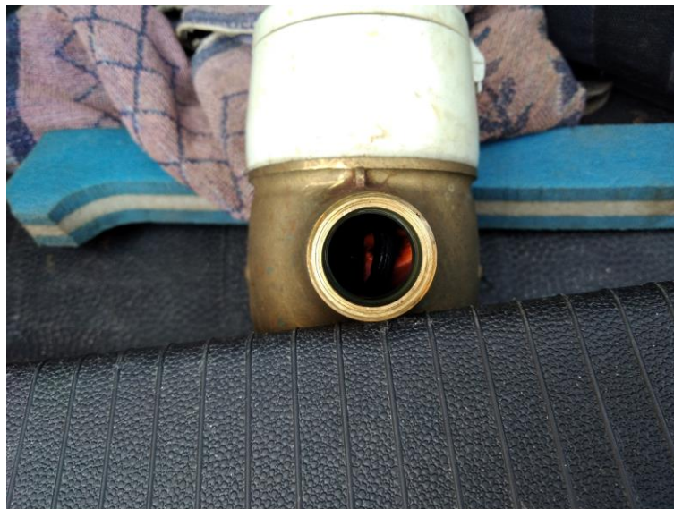
Figura 60 - Selo de corte dentro de contador
