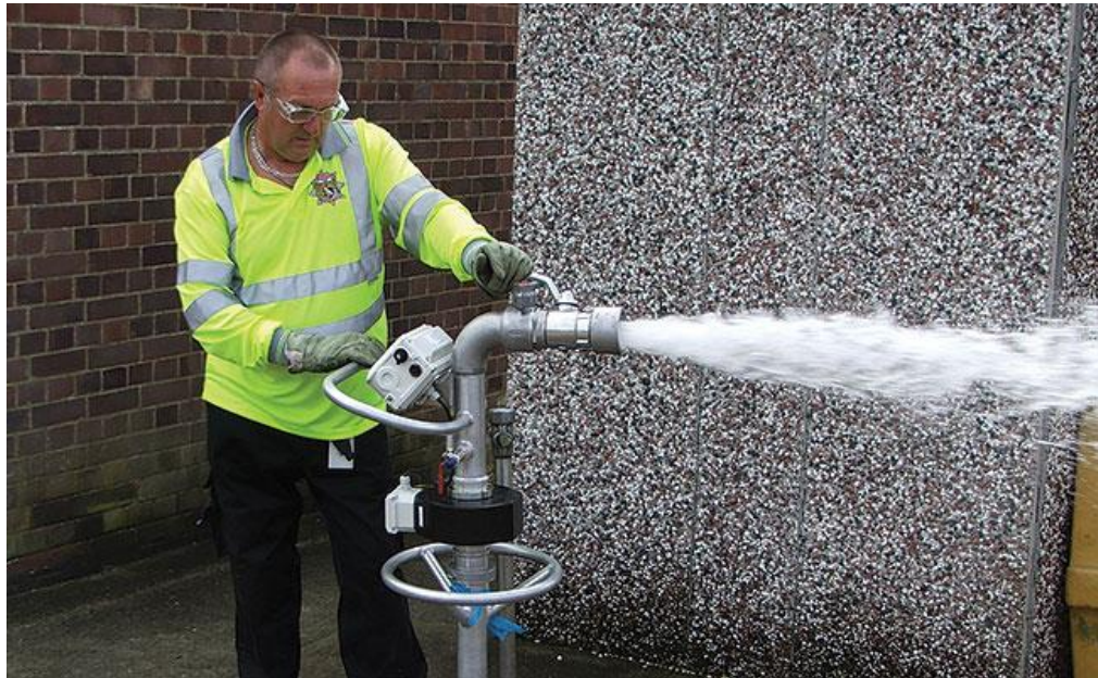
Figura 20 - Representação de um contador em conduta vertical (Mercom Water Products 2019).
