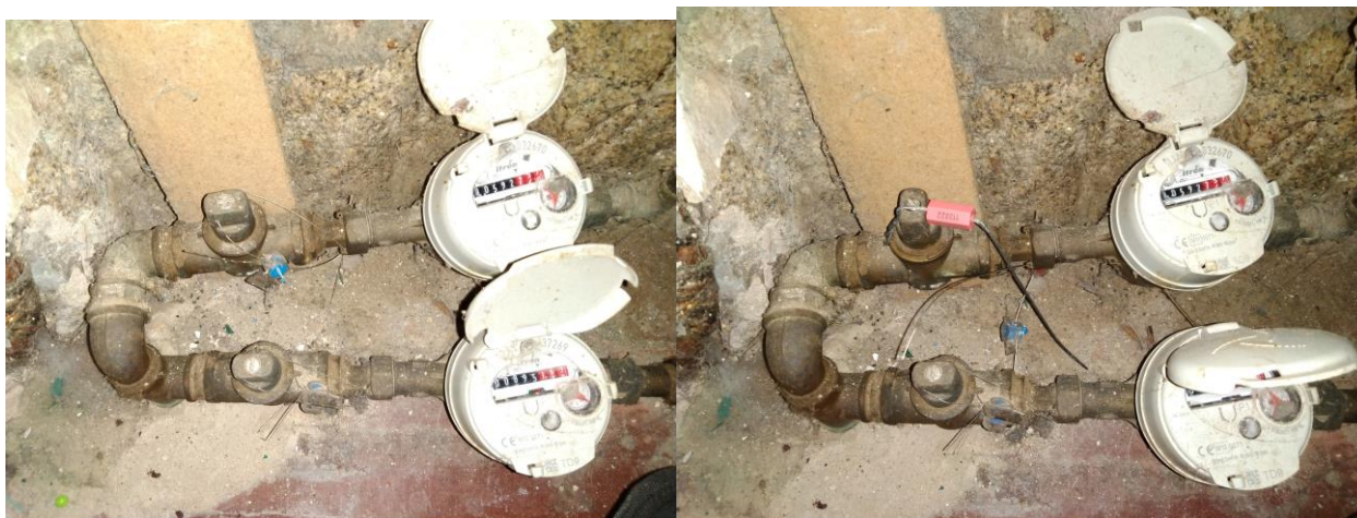
Figura 56 - Colocação do selo de corte
