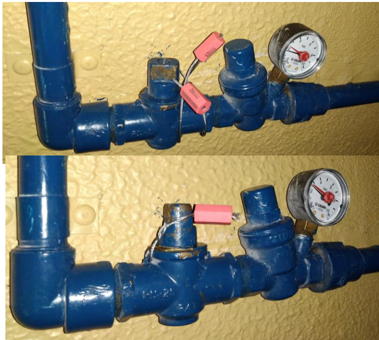
Figura 54 - Selo na adufa, duplamente violado e posterior reposição da legalidade
