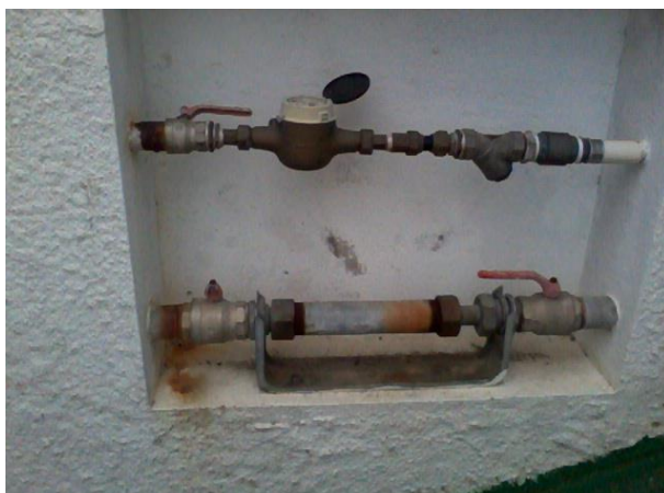
Figura 29 - Ligações diretas nos berços dos contadores
