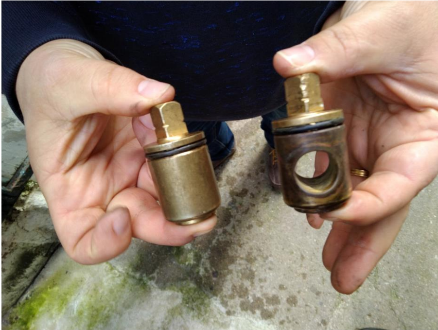
Figura 40 - Adufa normal à direita e macho cego à esquerda.
