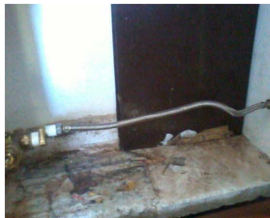
Figura 29 - Ligações diretas nos berços dos contadores
