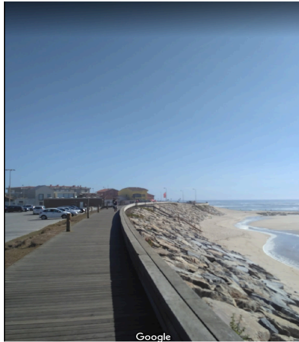
Figura 32- Estrutura aderente em enrocamento, Mindelo (Google Maps)
