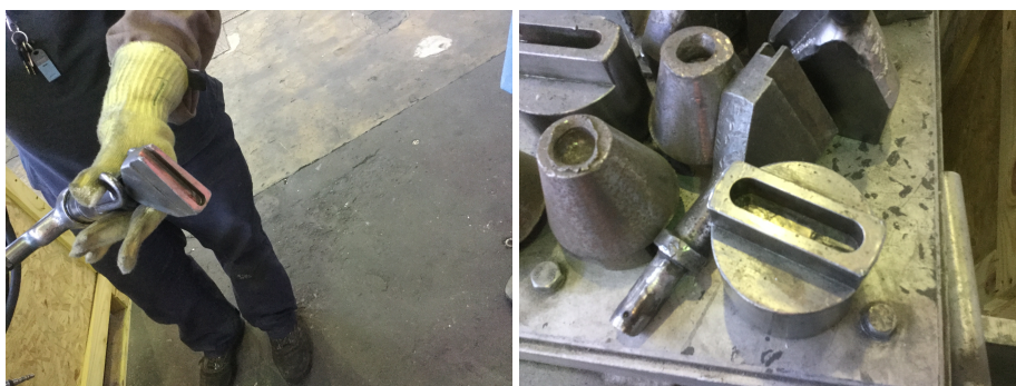
Figura 2.12 - Ferramentas adequadas à secção da barra e martelo pneumático
