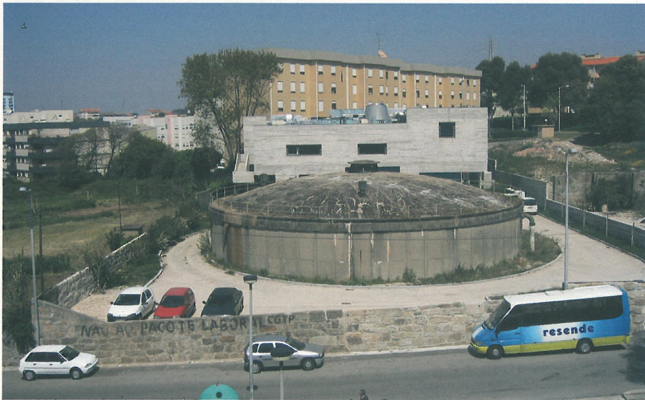
Fig. 2 - IAREN. Instituto da Água da Região Norte, 2000-2006. Rua General Torres, Matosinhos.
