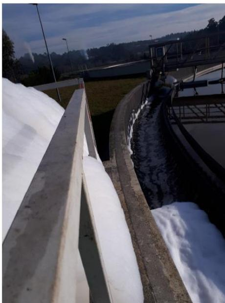
**Figura 2.7** - Fotografia do aspeto da saída do decantador secundário da ETAR do Ave (Adotado de Efacec, 2018).
