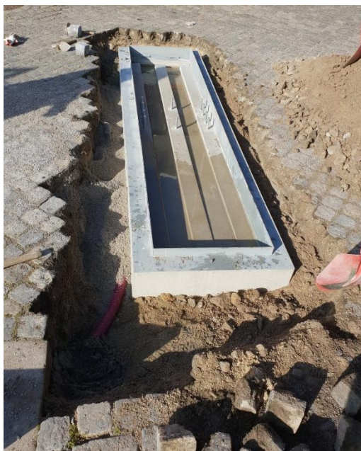
Figura 34 - Instalação da caixa de betão que irá suportar o sistema PEH, em Matosinhos
