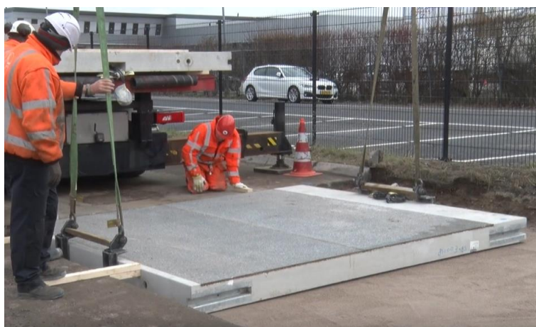
Figura 23 - Pormenor da instalação do PPF SolaRoad na Holanda (SolaRoad)
