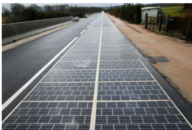
Figura 21 - 1 Km da solução PPF Wattway na Normandia, França ( Wattway )
