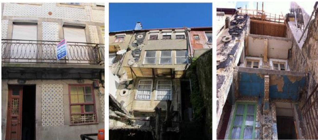
Figura 3. 5 - Fachadas da frente e de tardo do edifício C
