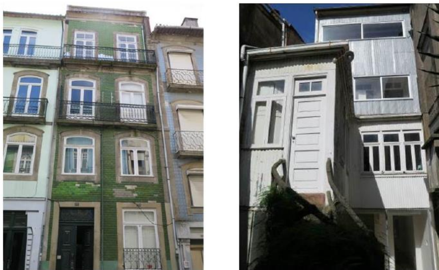
Figura 3. 10 - Fachadas da frente e de tardoiz do edifício G
