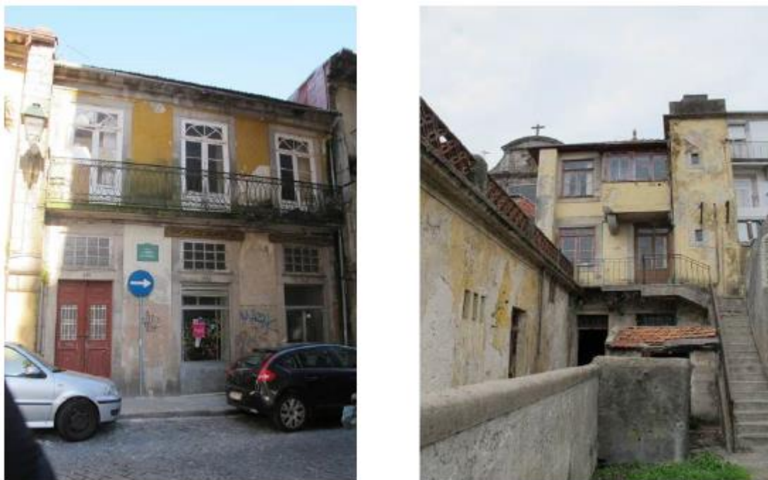
Figura 3. 2 - Fachadas da frente e de tardo do edifício A
