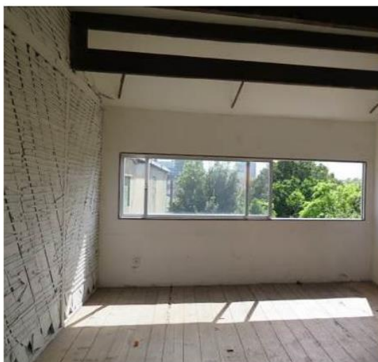
Figura 3. 9 - Parede em tabique duplo (esquerda) de suporte à cobertura
