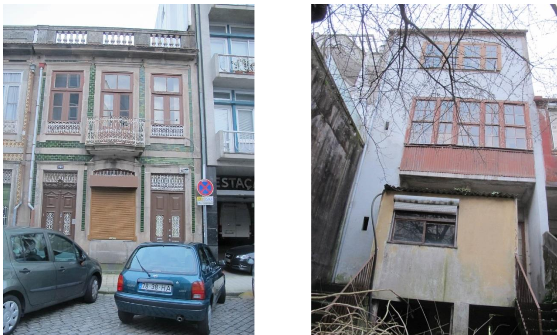
Figura 3. 6 - Fachadas da frente e de tardoz do edifício D
