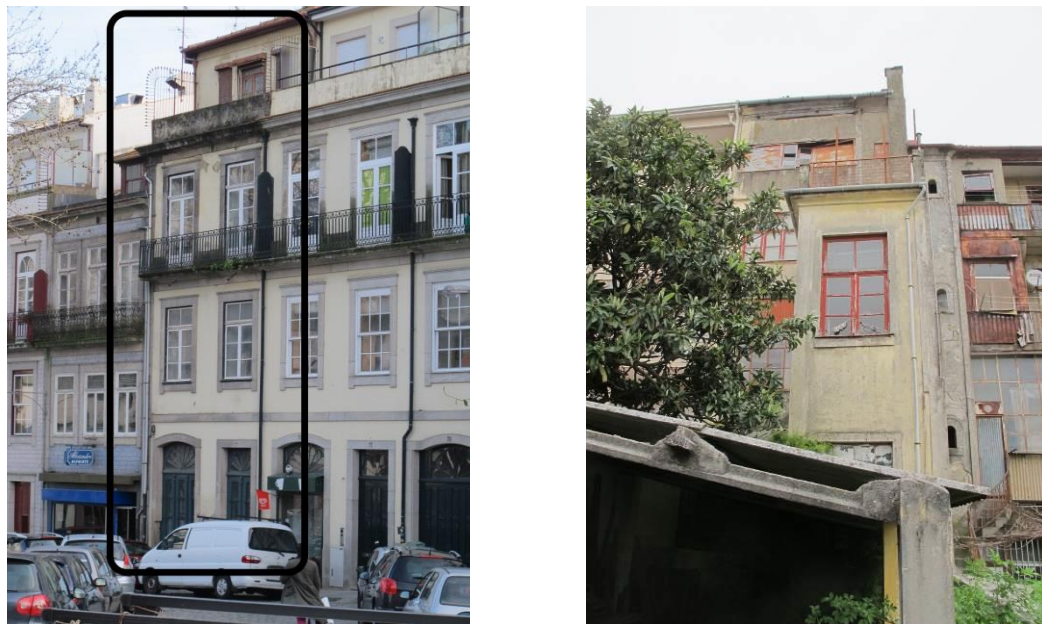
Figura 3. 7 - Fachadas da frente e de tardoiz do edifício E
