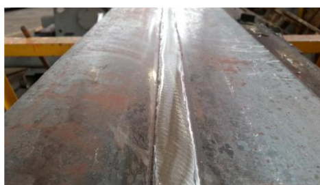
Figura 78: Reparação finalizada por HTBW.
