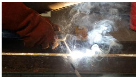
Figura 21: Procedimento de soldadura por eletrodo revestido.
