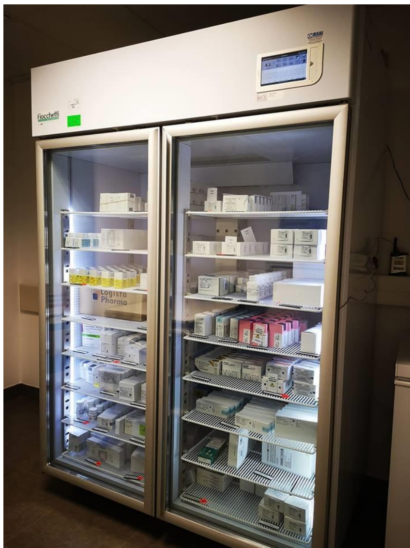
Anexo 47 - Frigoríficos da Sala de Armazenamento dos Medicamentos Experimentais.
