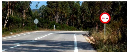
Fig.2.3. – Exemplo de sinalização e marcas rodoviárias
