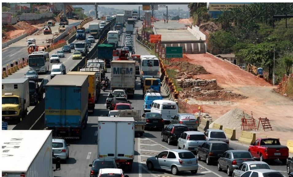
Fig.2.9. – Imagem que ilustra os impactos da obra sem interrupção de transito [39]
