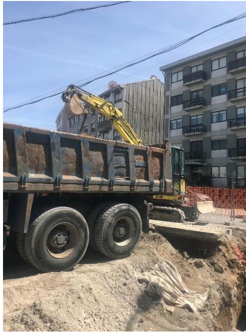
Fig.3.19. – Tarefa condicionada por estruturas existentes
