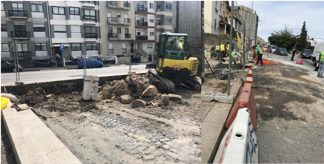
Fig.3.11. – Fotografias da zona Sul do estaleiro
