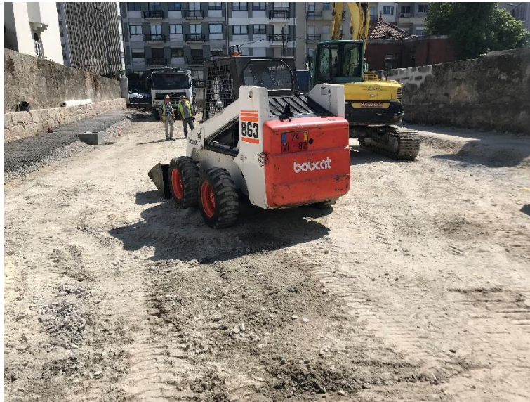
Fig.3.15. – Impossibilidade de conclusão da tarefa em execução devido às condicionantes do estaleiro
