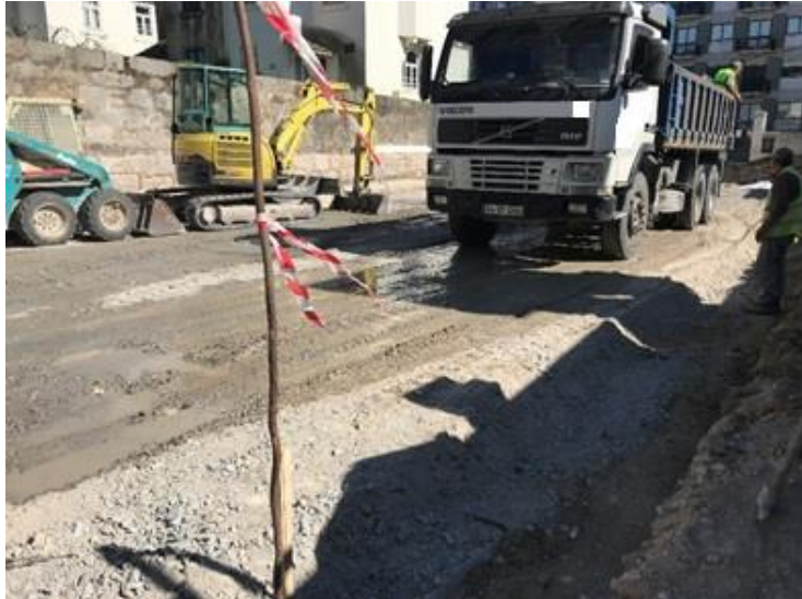
Fig.3.13. – Movimentação de equipamentos por falta de espaço no estaleiro
