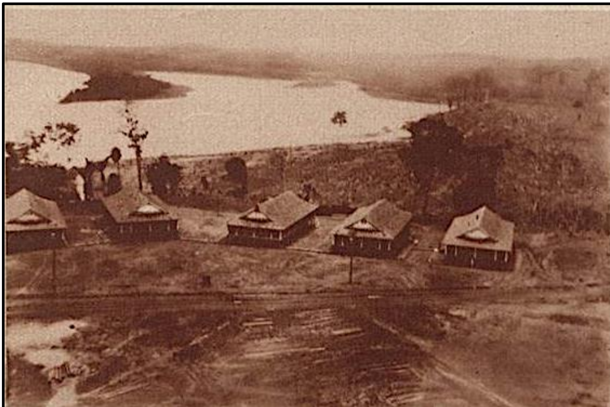
Figura 18: As primeiras estruturas em Fordlândia, ao fundo, o rio Tapajós, Brasil. Fonte: O cruzeiro, 12 de Dezembro de 1931.
