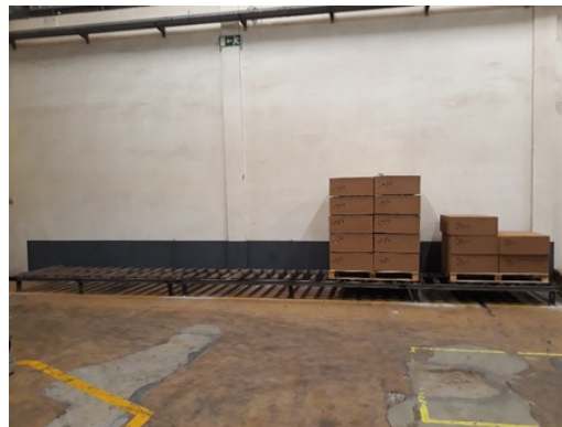
(c) Reparação de parede danificada.
