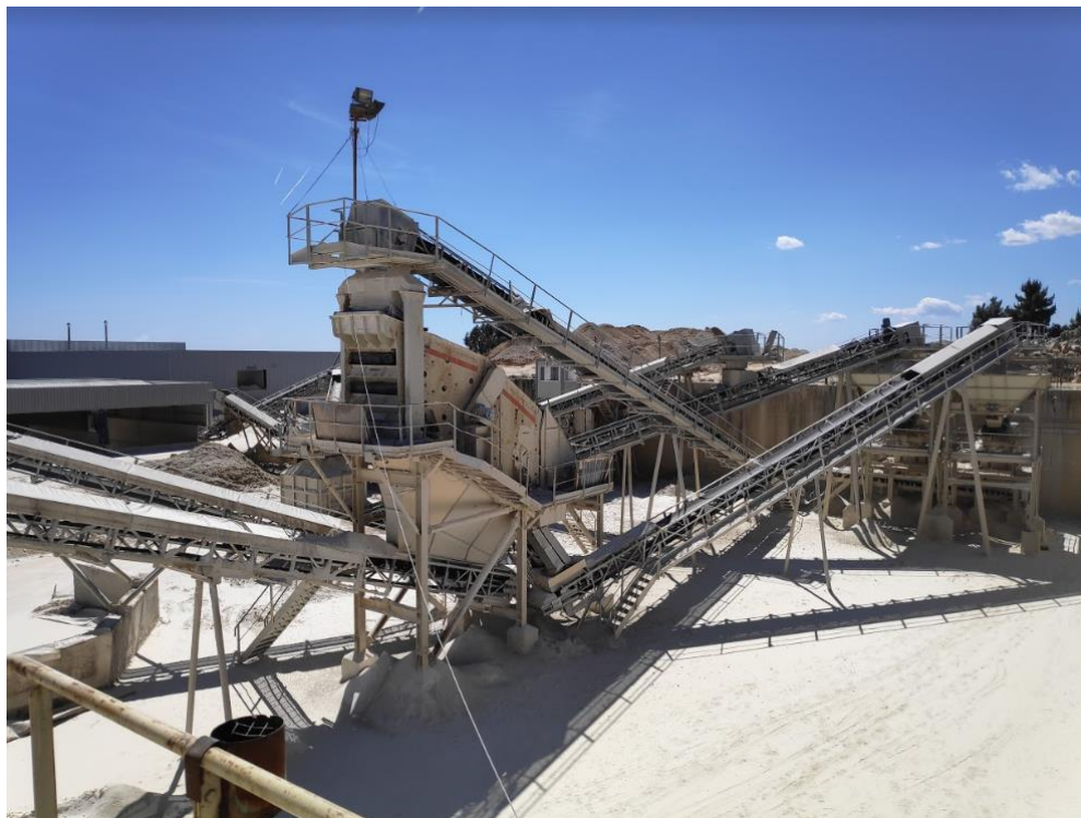
Figura 9 - Posto de observação do operador de controlo operacional
