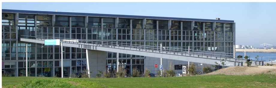
Figura 3.7 - Ponte pedonal monitorizada por sensores alimentados a energia solar (Moutinho e Cunha 2019)
