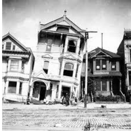
Fig. 5 – Danos a edifícios devido a liquefação após o sismo de 1906 em S. Francisco (swri.org)
