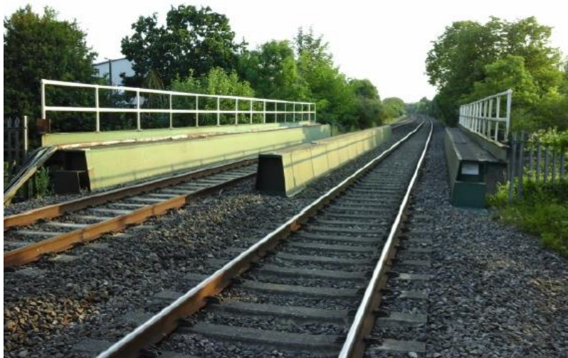
Figura 42 – Vias férreas sobre a Ponte de Bristol (Network Rail, 2017)
