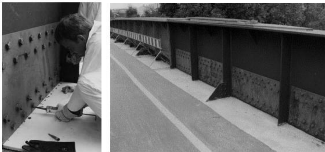
Figura 13- Reparação da alma da viga principal através de parafusos de injeção numa ponte em Oranienburg, Alemanha (Gresnigt et al., 2000)
