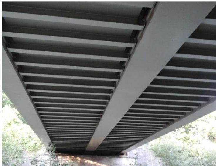
Figura 40 – Vista inferior da ponte de Bristol (Network Rail, 2017)
