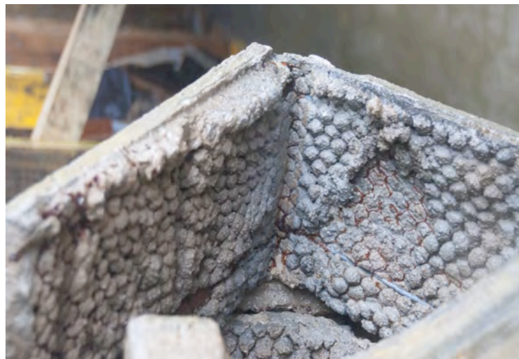
Figura 06 – Mísulas executadas em rede de arame tipo “galinheiro” e argamassa. Fonte: Autores, 2014
