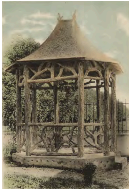
Figura 02 – Quiosque desmontável de betão armado de cimento de Vassy, para a Exposição Universal de 1900. Fonte: (Société Anonyme des Ciments de Vassy 1906)
