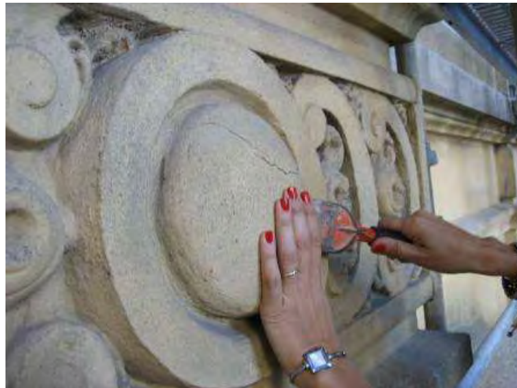
Figura 06 – Recolha de amostras no TNSJ. Fonte: (Velosa et al. 2011)
