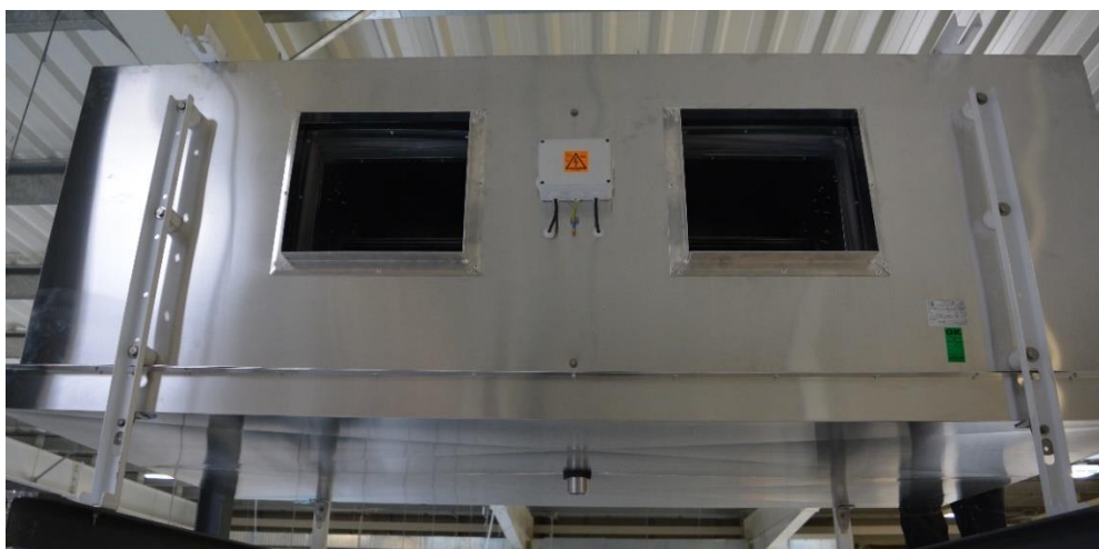
Figura 35 - Evaporador Centauro série KDM.
