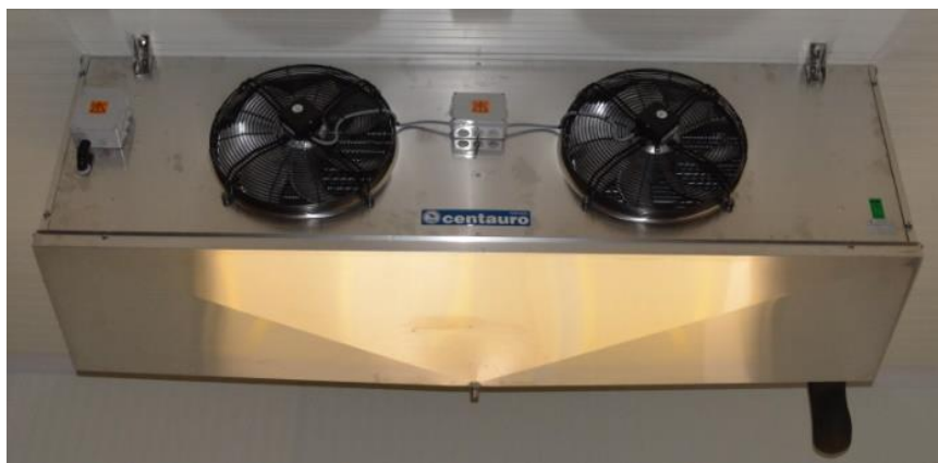
Figura 36 - Evaporador DD/E da Centauro.
