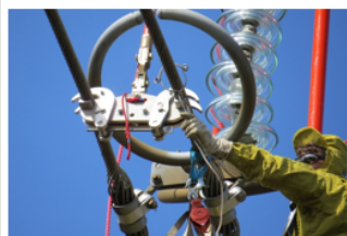
Intervenções em linhas aéreas MAT
