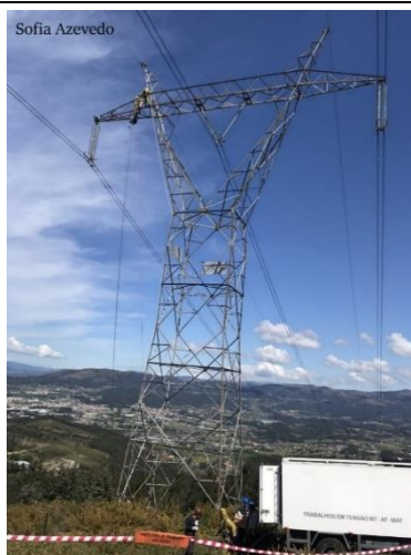
Figura 4 - Linha de Muito Alta Tensão - 400 kV
