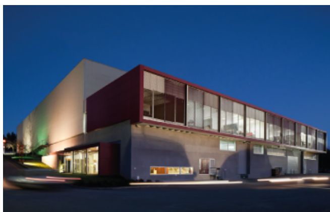
Figura 1.2: Instalações da Quantal em Vila do Conde (Quantal, 2019).
