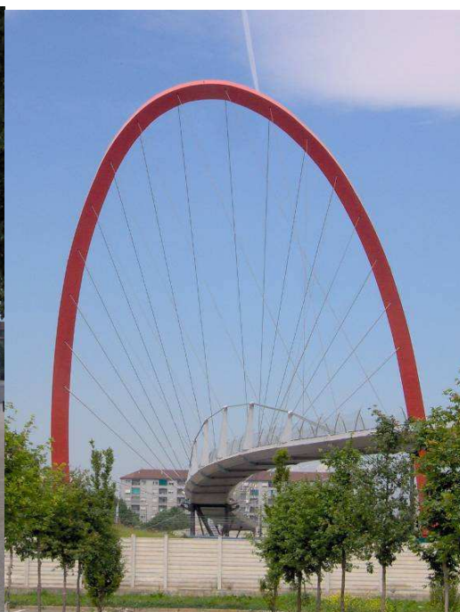
Foto 71 - Arco da Passarela de interligação da Vila Olímpica com o edifício Lingotto
