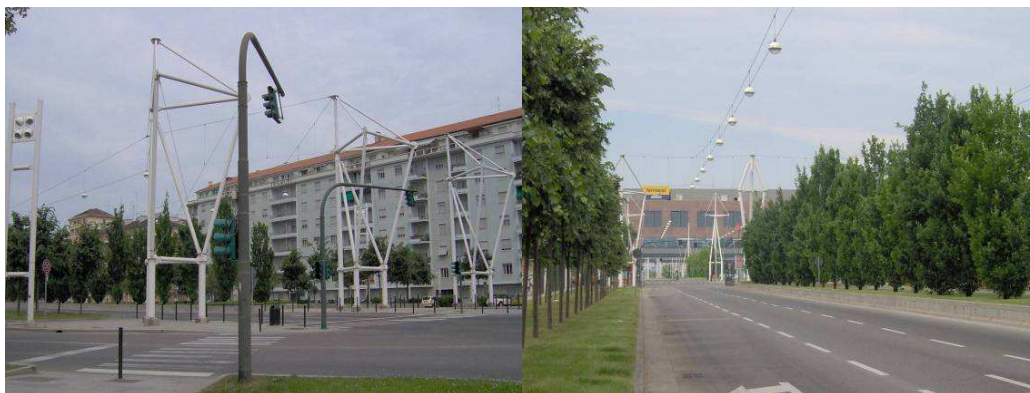
Fotos 80 e 81 - Passante Ferroviário
