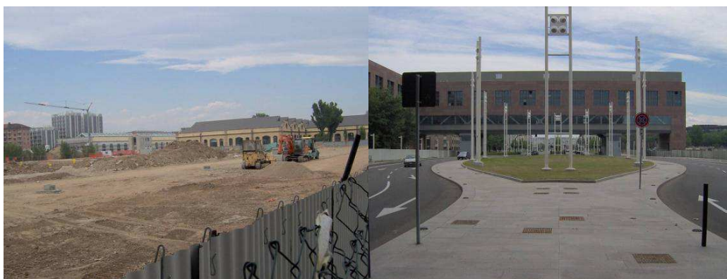
Fotos 82 e 83 - Ampliação do Instituto Politécnico no Passante Ferroviário
