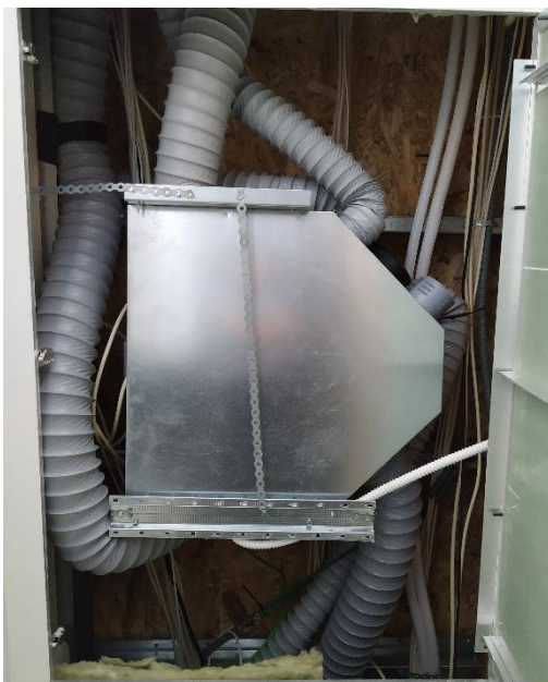
Fig. 30 - Sistema de ventilação mecânica do protótipo.
