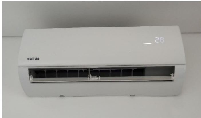
Fig. 29 - Aparelho de ar condicionado do Protótipo.
