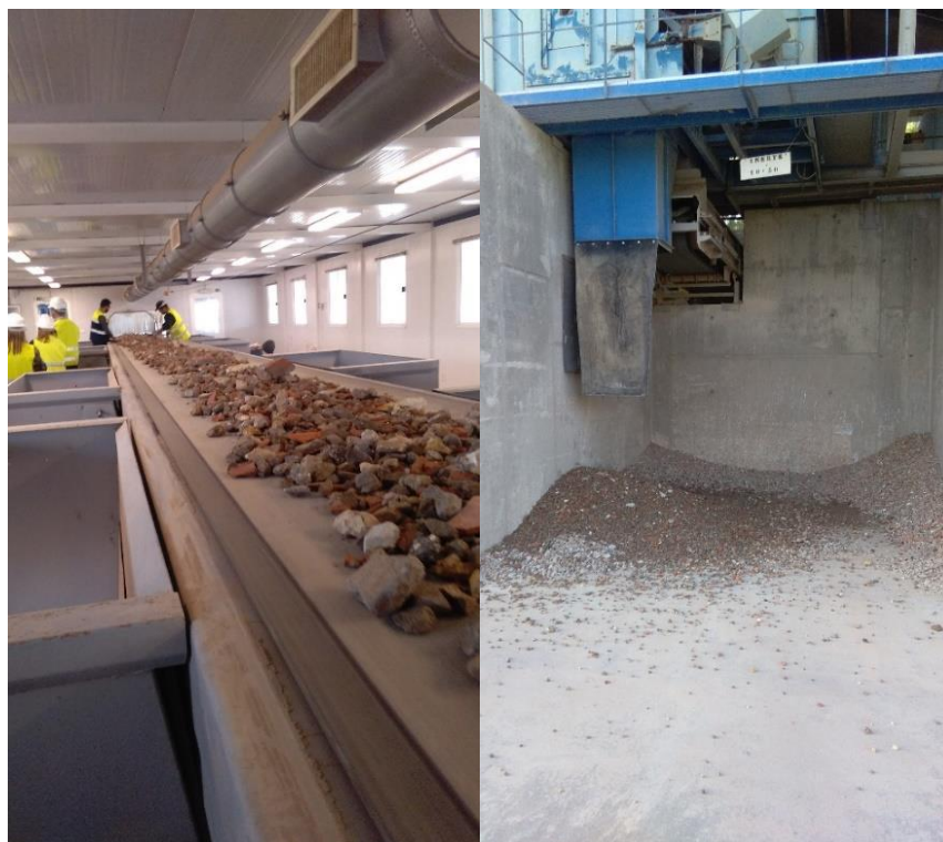
Figura 5 – Cabine de triagem de RCD e agregado reciclado nas instalações da RCD – Resíduos de Construção e de Demolição, S.A.
