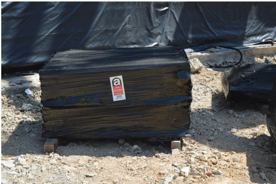
Figura 2 – Chapas de cobertura de fibrocimento contendo amianto removidas na empreitada de reabilitação da plataforma interior da Lipor
