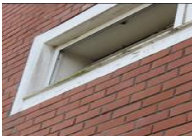
Fig.40 – Representação fotográfica da anomalia tipo “ Sujidade”.
