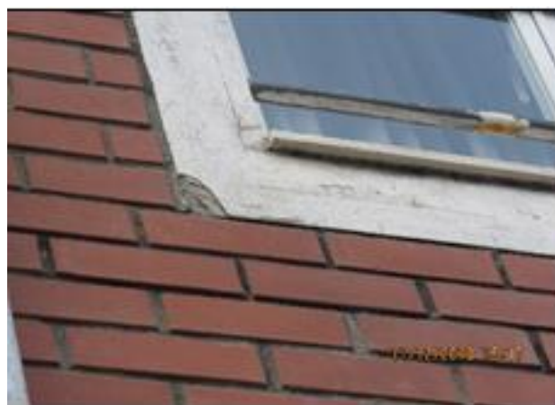
Fig.35 – Representação fotográfica da anomalia tipo "Destacamento".
