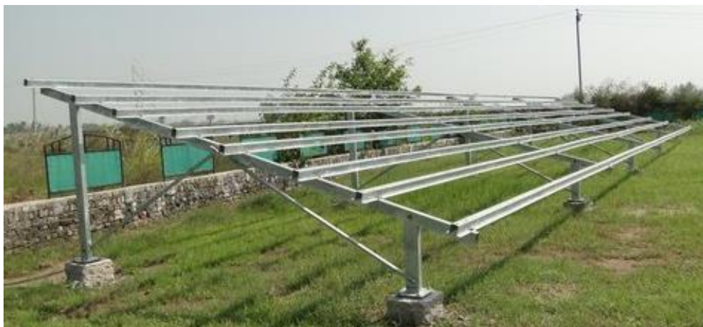
Figura 4 – Exemplo de recurso a madres com seção em \Omega (Go Green Renewable Energies (P) Ltd, India)
