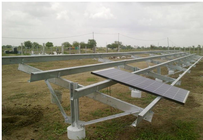
Figura 3 – Exemplo de utilização de madres com seção em Z (Sanghvi Ispat Industries, India)
