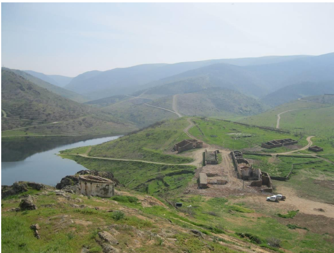
Fotografia 20: Albufeira do AHBS em plena fase de enchimento na Quinta de Crestelos (18/03/2014)
