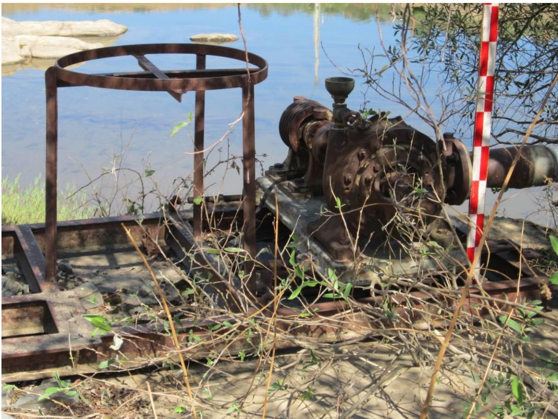
Fotografia 41: Motor de extração de água da Quinta de Crestelos, situado junto do leito do rio Sabor ao Poço do Remanso
