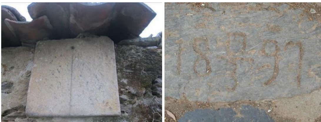
Foto 04 e 05: relógio solar, muito desgastado, em alçado e data gravada em laje de xisto
