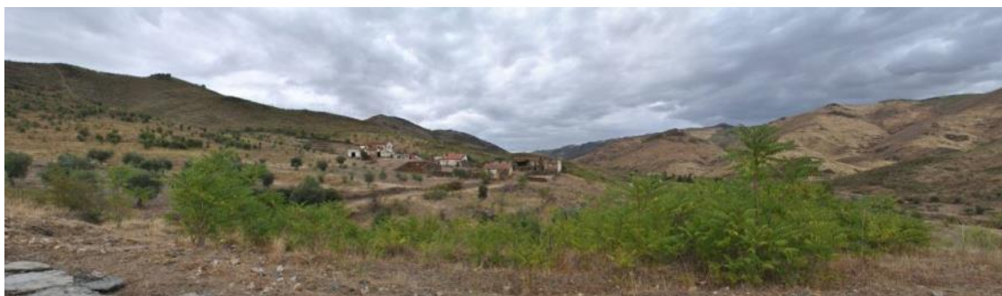
Foto 16: Edificado central do núcleo visto desde a eira.
