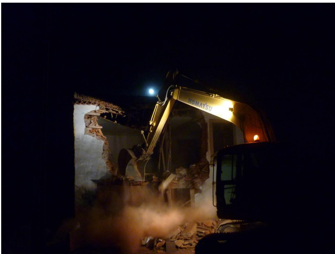
Fotografia 19: Trabalhos de demolição, noturna, do núcleo central edificado de Crestelos (19/11/2013)
