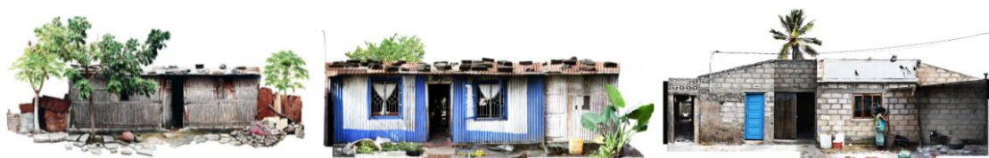
Figura 53: as três formas construtivas nos BAP de Maputo: a casa de caniço (à esquerda); a casa de chapa de zinco (no meio); a casa de bloco de cimento (à direita) Fonte: (Eskemose e Mottelson, 2016, p.13)
