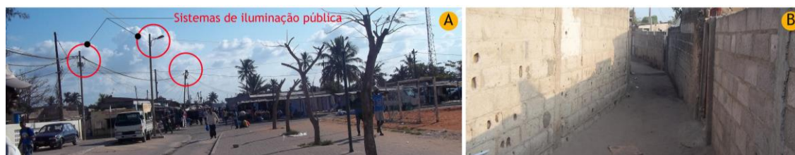
Figura 38: Iluminação pública no BGD
