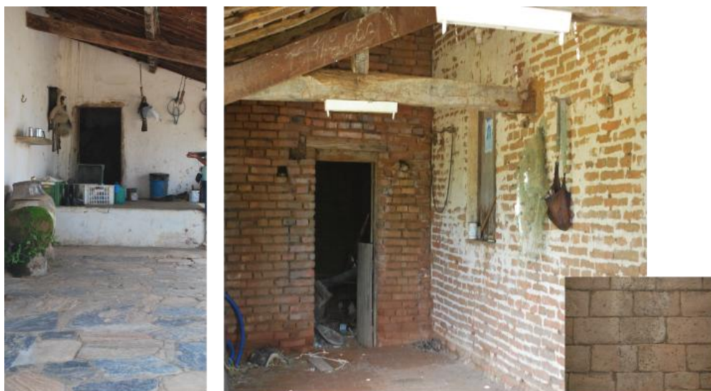
Figura 42. Piso em lajeado de pedra e tijoleira de barro dos Alpendres das casas-grandes Umary e Encampinado. Fonte: Adaptação da autora (2019) a partir de imagens do arquivo do relatório técnico (Assunção, Oliveira, & Silva, 2010)
