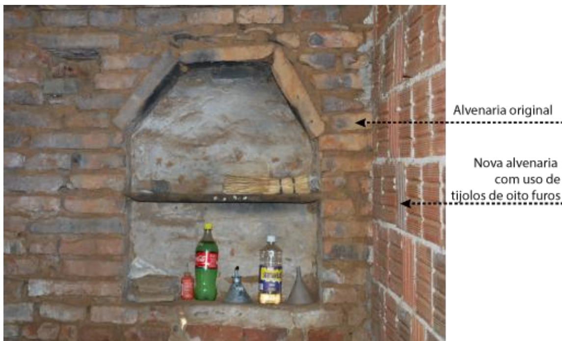
Figura 61. Alvenarias original e nova da casa-grande Encampinado. Fonte: Autora, 2019.
