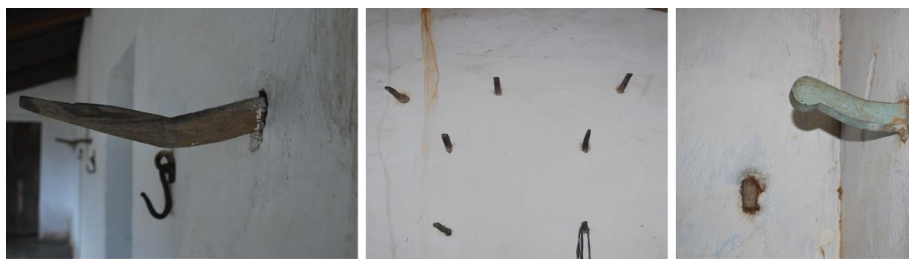
Figura 44. Tornos dos Alpendres de Três Riachos, Umary e Amparo. Fonte: Adaptação da autora (2019) a partir de imagens do arquivo do relatório técnico (Assunção, Oliveira, & Silva, 2010)
