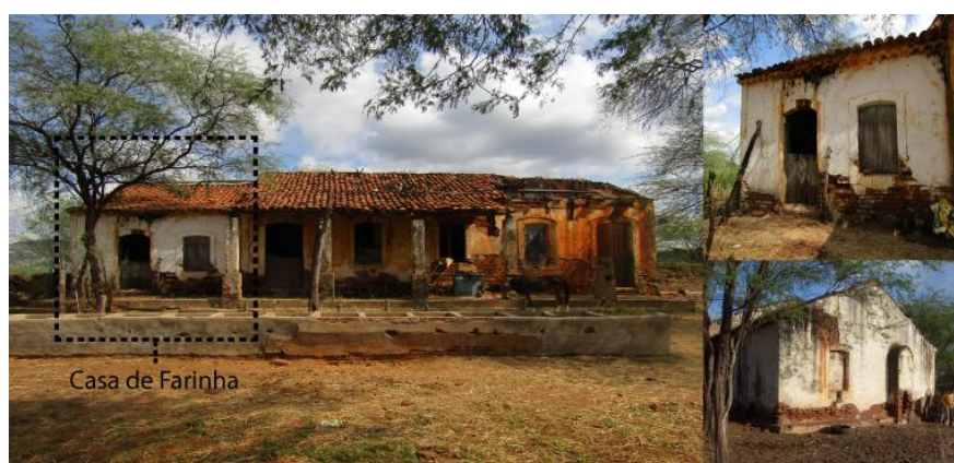
Figura 37. Casa de farinha contígua a Casa-grande Dinamarca. Fonte: Autora, 2019.
