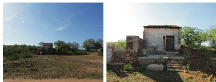
Vista da fachda principal do edificado restante da casa-grande vapor
