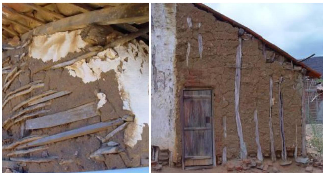
Figura 29. Sistema construtivo em taipa. Fonte: (IPHAN, 2012, p.51)
