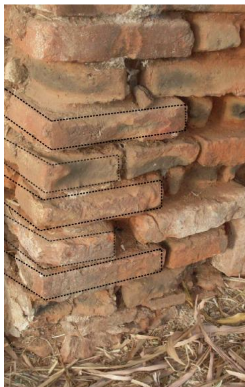
Figura 59. Assentamento tijolos.
