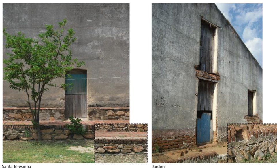
Figura 62. Alicerce em pedras mistas das casas-geande Santa Teresinha e Jardim. Fonte: Adaptação da autora (2019) a partir de imagens do arquivo do relatório técnico (Assunção, Oliveira, & Silva, 2010)
