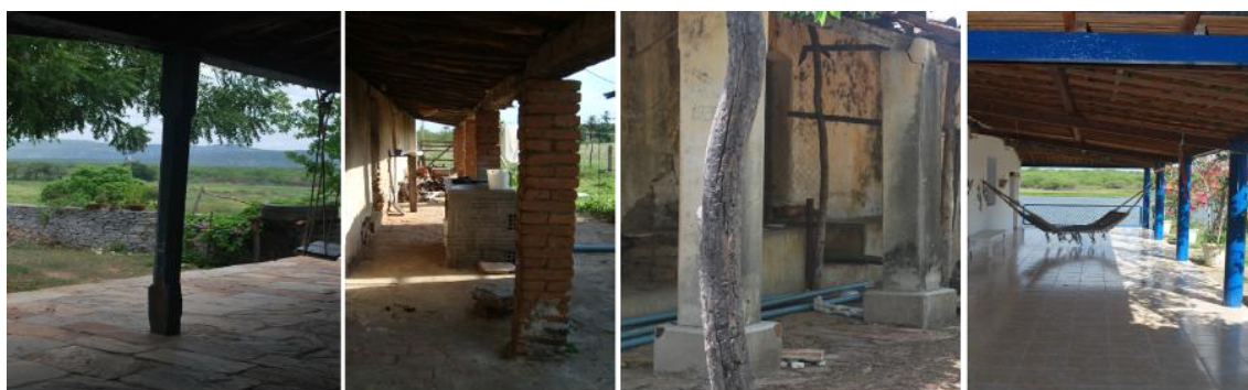
Figura 41. Estrutura do pilares dos Alpendres: madeira, tijoleira de barro, alvenaria e PVC, respectivamente. Fonte: Adaptação da autora (2019) a partir de imagens do arquivo do relatório técnico (Assunção, Oliveira, & Silva, 2010)
