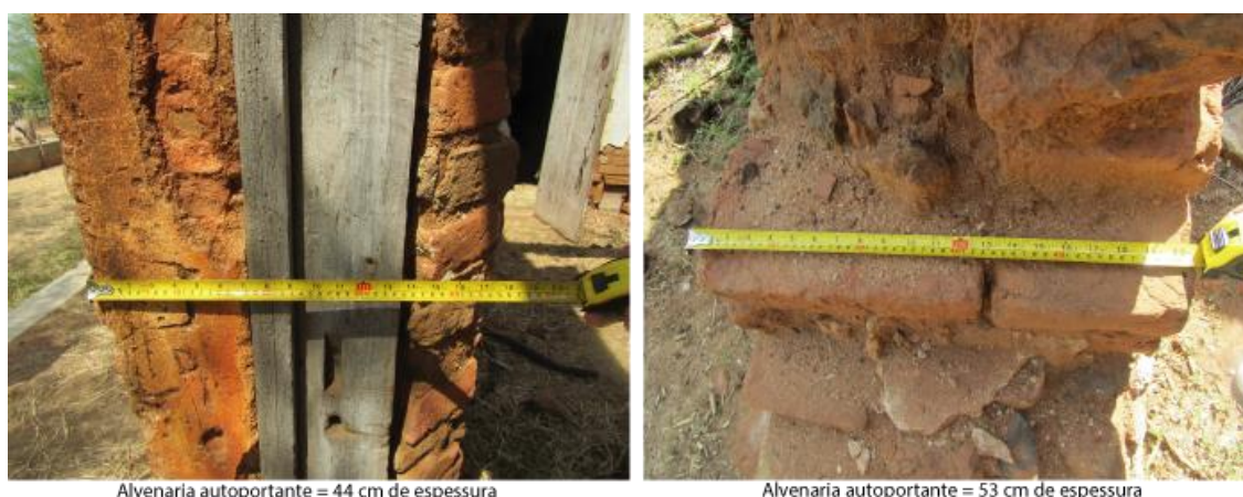
Figura 60. Alvenarias da casa-grande Dinamarca. Fonte: Autora, 2019.
