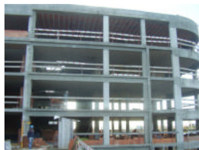
Figura 5 – Bloco B – "Obra Aberta"
