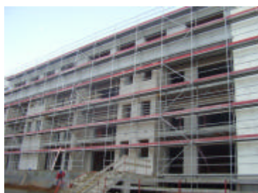
Figura 4 - Bloco A - "Obra Fechada"
