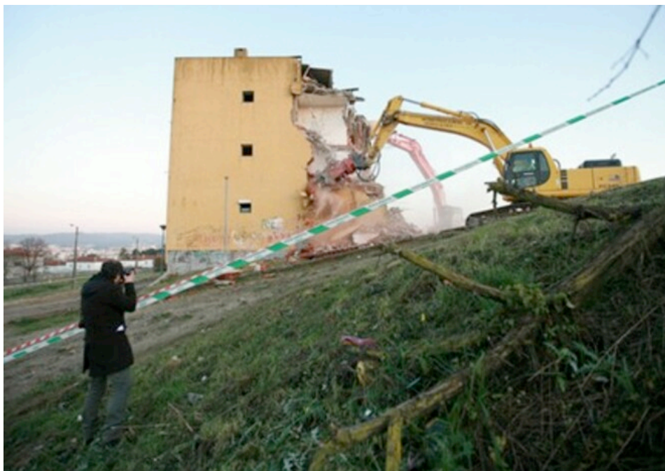
Imagem 18- Fase de demolição do bairro São João de Deus in https://www.jn.pt/local/noticias/porto/porto/interior/camara-do-porto-vai-demolir-casas-junto-ao-bairro-sao-joao-de-deus-5770273.html
