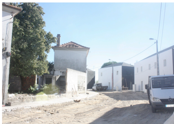
Imagem 65 - Fase de construção do Bairro São João de Deus
