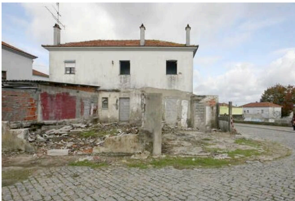
Imagem 17 - Fase de demolição do bairro São João de Deus in https://www.jn.pt/local/noticias/porto/porto/interior/camara-do-porto-vai-demolir-casas-junto-ao-bairro-sao-joao-de-deus-5770273.html
