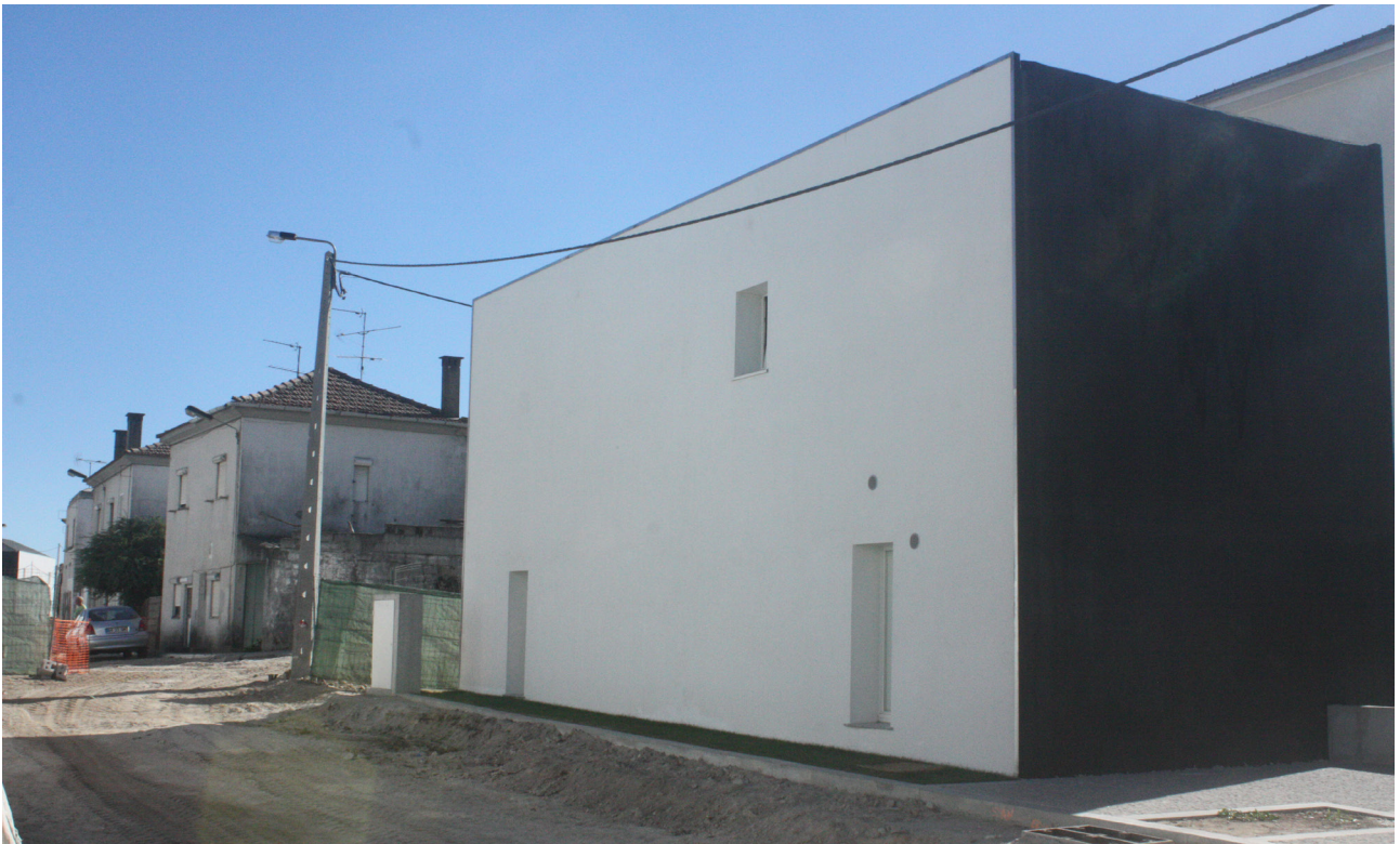
Imagem 40 - Projeto de requalificação do Bairro São João de Deus - Fotografia de autora
