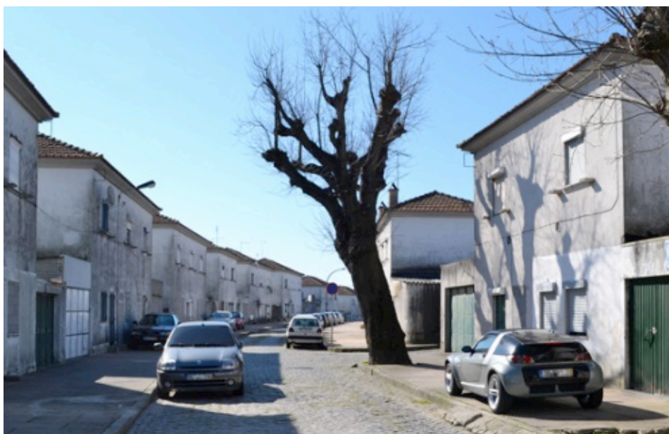
Imagem 19 - Bairro São João de Deus in http://www.domussocial.pt/noticias-domus/camara-do-porto-inicia-construcao-das-novas-casas-do-bairro-sao-joao-de-deus
