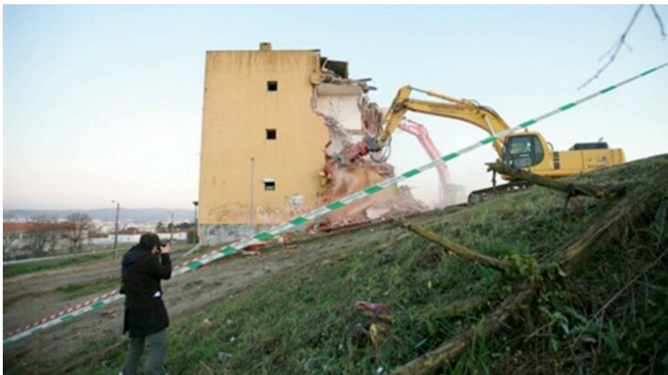
Imagem 67 - Processo de demolição dos blocos do bairro São João de Deus in https://www.jn.pt/local/noticias/porto/porto/interior/bairro-sao-joao-de-deus-volta-a-agitar-assembleia-municipal-do-porto-2897121.html
